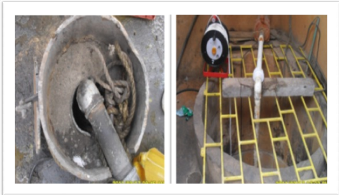
Figura 4.1 Protección Inadecuada Pozo y Cisterna
