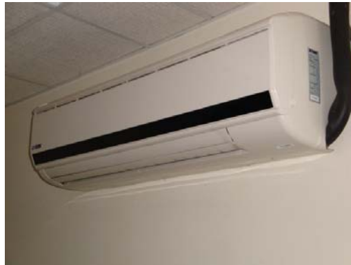
Fig. 6 Acondicionador tipo Mini Split
