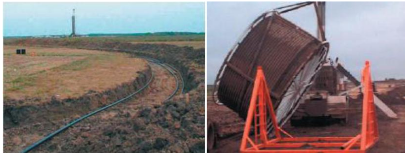
Figura 13. Instalación Tubería Fibra de Vidrio.
