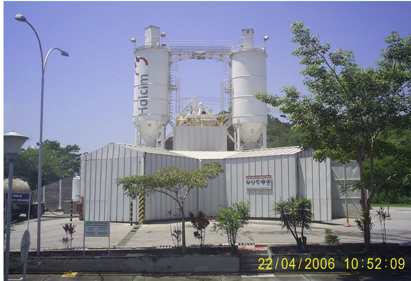
Figura 3.4. Instalaciones de Mezclado y Producción de Concreto Holcim Floridablanca
