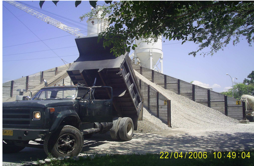
Figura 3.1. Sistema de Almacenamiento de agregados Planta Holcim-Floridablanca
