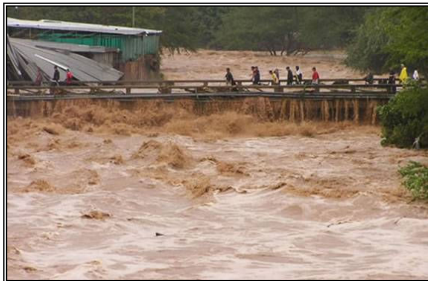
Figura 4. Puente Lenguerke – Municipio de Girón
