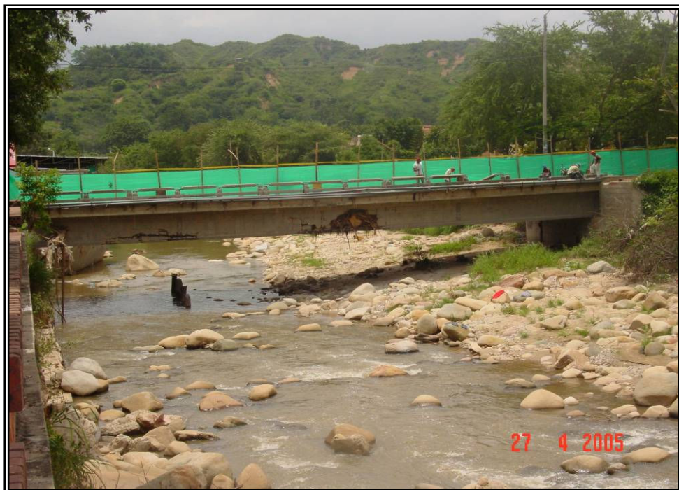
Figura 46. Fotografía Puente GEO Von Lenguerke.
