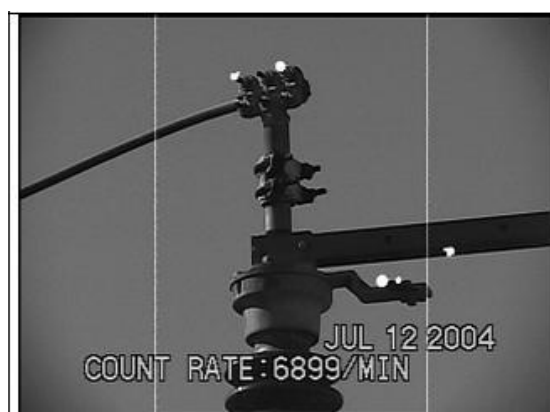
Figura 47. Morseto de conexión a seccionador de 150 kV y contacto de seccionador de puesta a tierra.
