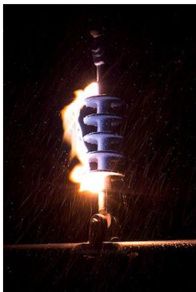
Figura 48. Arco eléctrico en aislador
