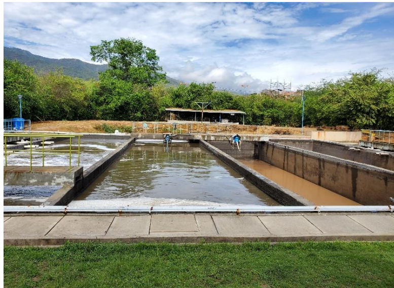
Figura 3. PTAR Ciudad Nuevo Girón.
