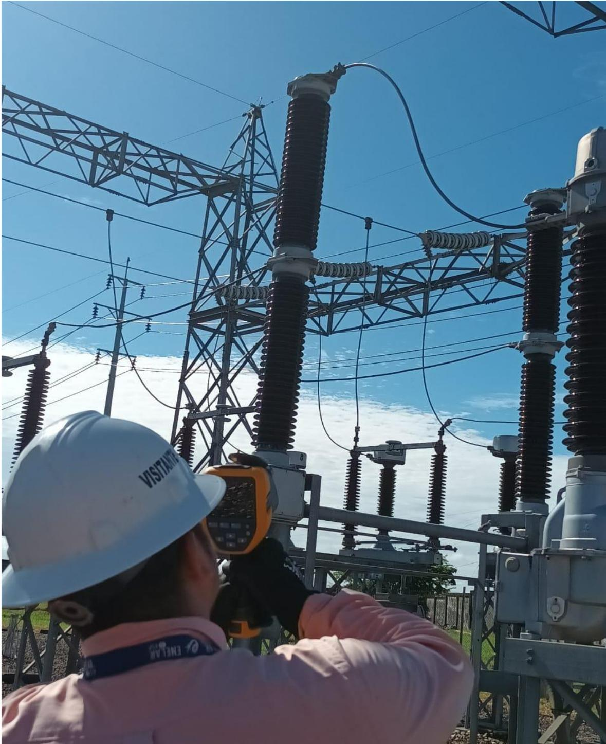
*Imagen 53. . Inspección termográfica en nivel de tensión III Interruptor T189 en S/E Tame – Fuente: Autor*
