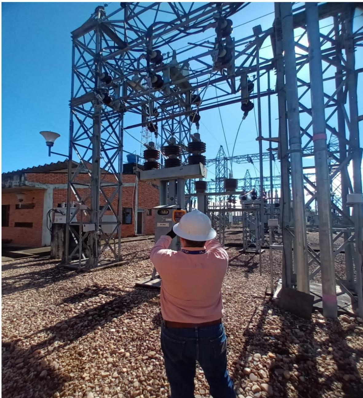
*Imagen 49. Inspección termográfica en nivel de tensión III interruptor CRA34 en S/E Tame – Fuente: Autor*
