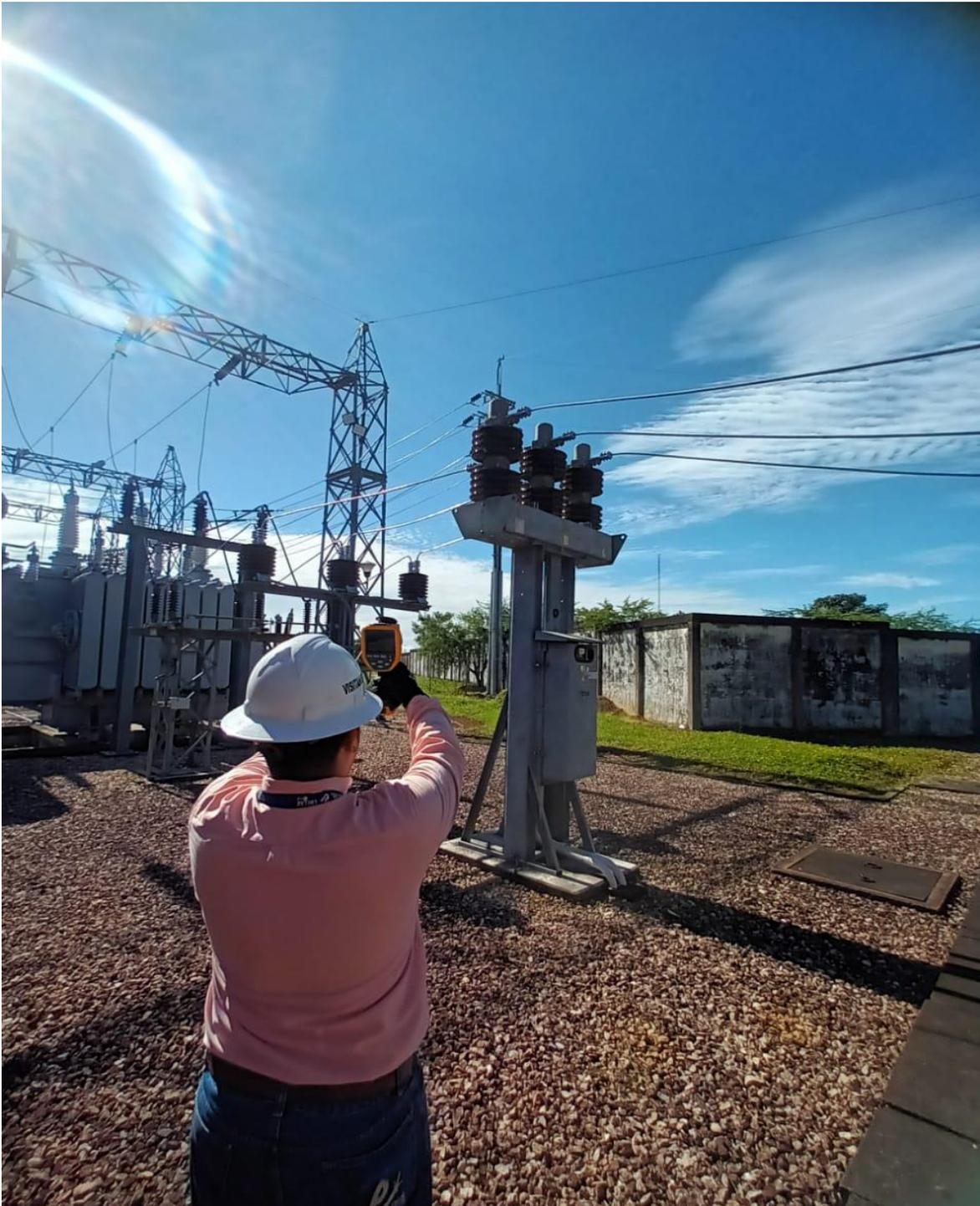
*Imagen 51. Inspección termográfica en nivel de tensión III Interruptor T252A en S/E Tame – Fuente: Autor*
