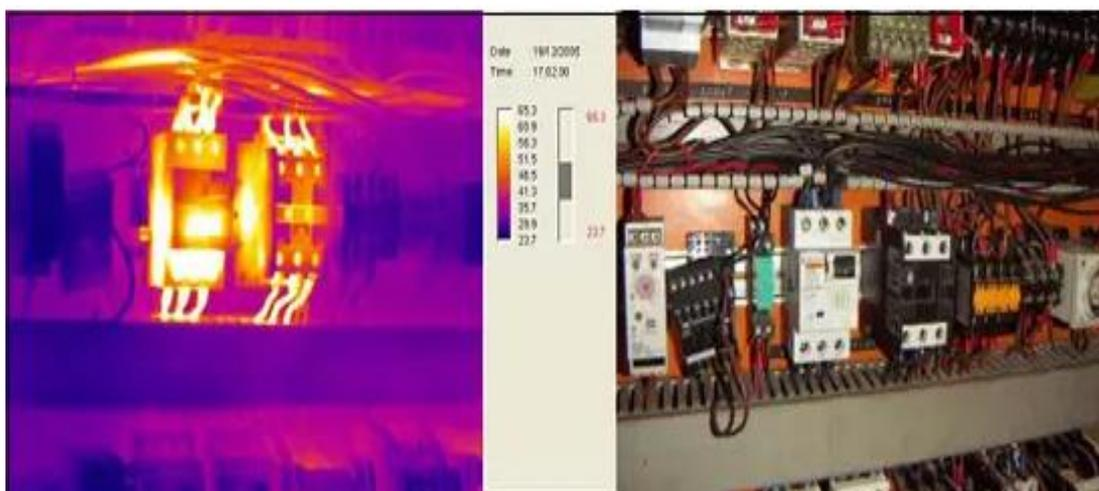
Imagen 26. Imagen termográfica de dispositivos de protección sobrecargados – Fuente: Indunova “Termografía: ¿Cuáles son las causas que originan puntos calientes en un sistema eléctrico?”, <https://indunova.es/termografia-cuales-son-las-causas-que-originan-puntos-calientes-en-un-sistema-electrico/>
