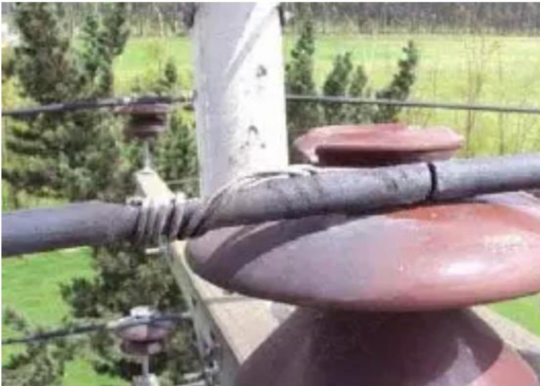
*Imagen 20. Conductor semi-aislado afectado por tracking eléctrico – Fuente: Mario Ricardo Cárdenas Barrero, Miguel Eugenio Garzón artículo “DIAGNÓSTICO DE REDES DE DISTRIBUCIÓN AÉREAS DE 11,4 HASTA 34,5 KV CON LA TÉCNICA DE ULTRASONIDO.”*
