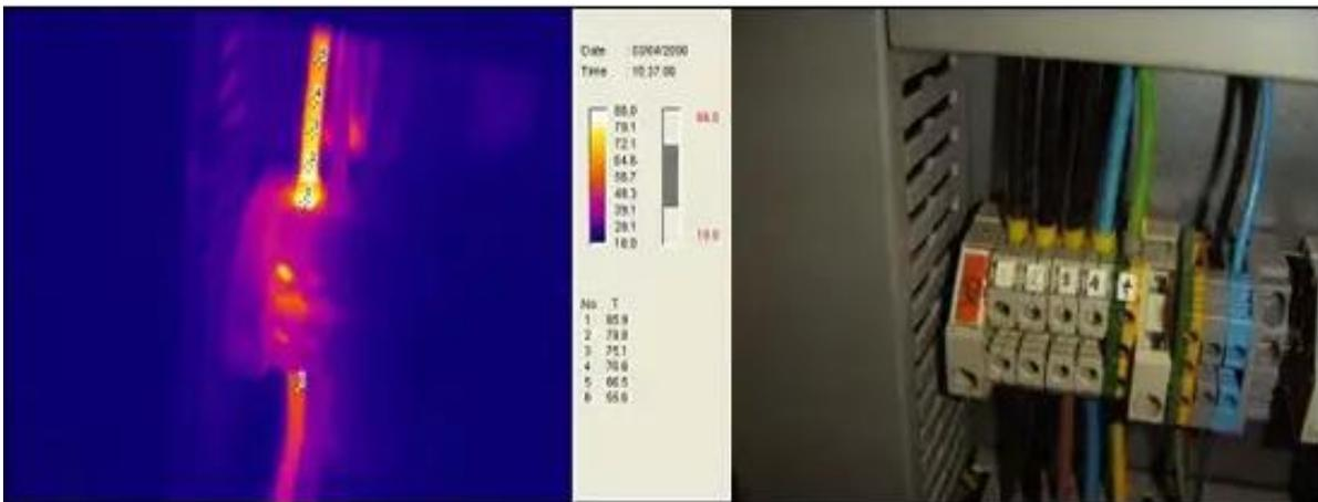
Imagen 24. Disminución progresiva del gradiente térmico en relación con la distancia al punto caliente – Fuente: Indunova “Termografía: ¿Cuáles son las causas que originan puntos calientes en un sistema eléctrico?”, <https://indunova.es/termografia-cuales-son-las-causas-que-originan-puntos-calientes-en-un-sistema-electrico/>
