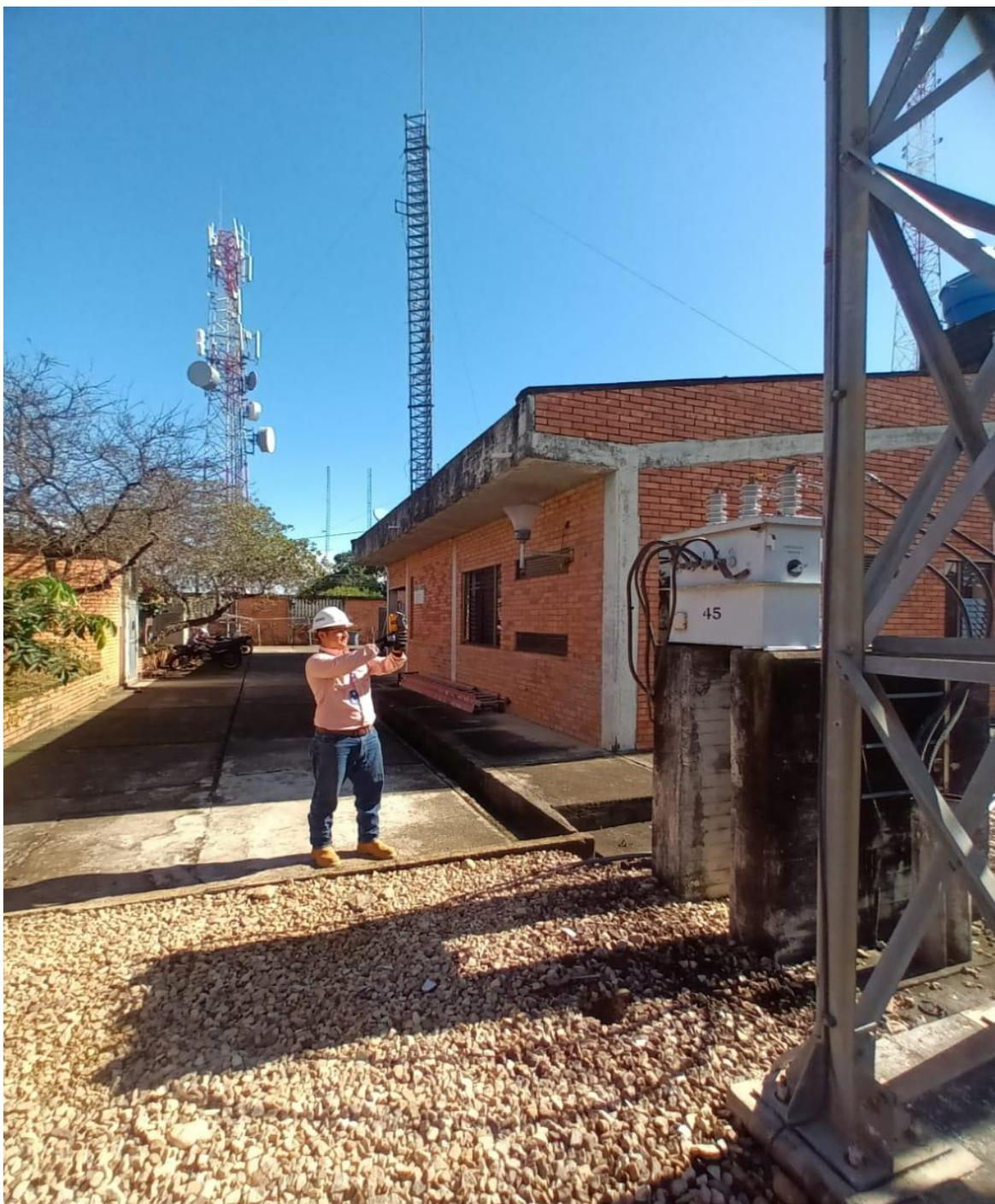
*Imagen 45. Inspección termográfica en nivel de tensión II transformador de servicios auxiliares en S/E Tame – Fuente: Autor.*
