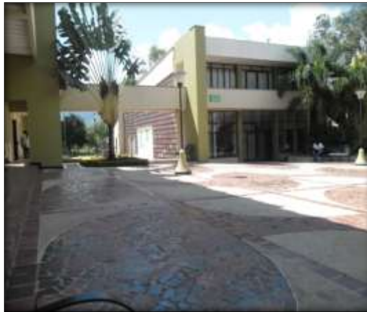
Figura 1. Vista general de estructura.
