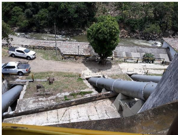
Figura 8. Vista superior de la planta de generación de energía La Cascada
