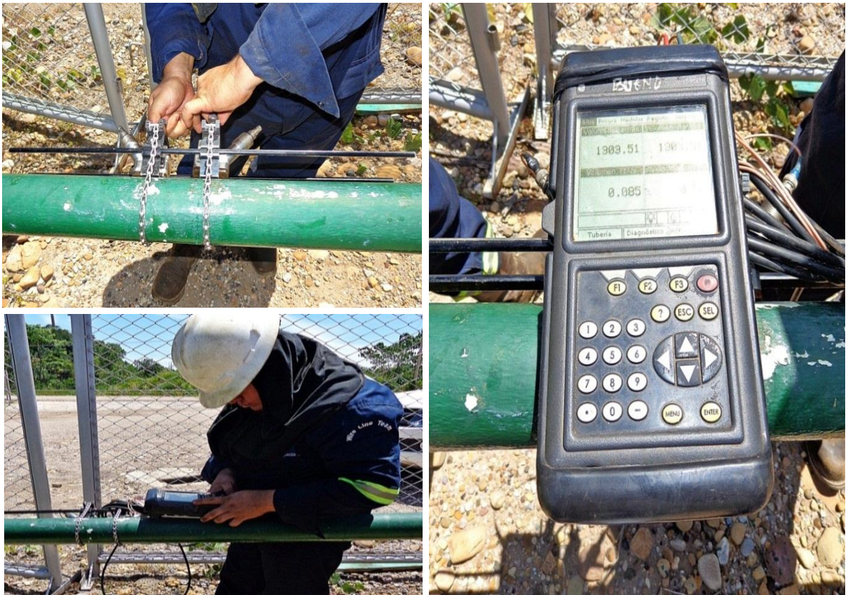
Figura 23. Montaje medidor de caudal Panametrics CO LREGISTROS S.A.S.
