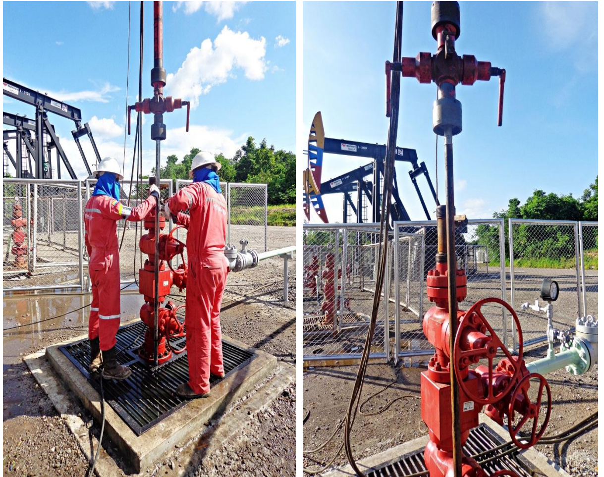
Figura 43. Montaje final sarta AFT en cabeza de pozo
