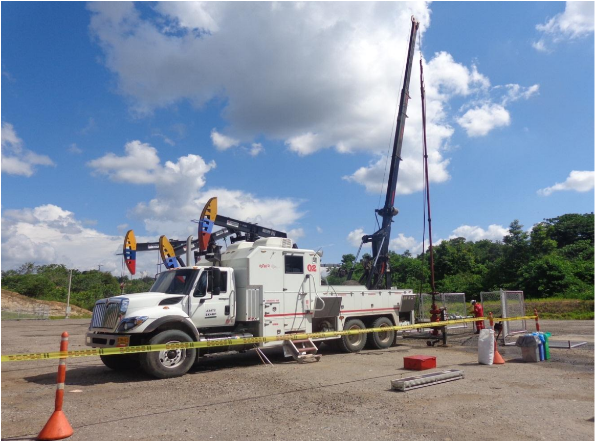
Figura 41. Anillo de seguridad en el perímetro de la operación.
