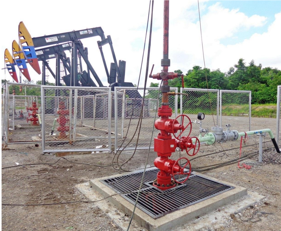
Figura 44. Acople Sarta HOTWELL COLOMBIA al pozo Inyector
