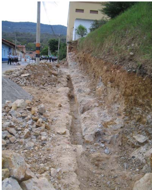
Fotografía 6. Excavación lateral para demoler totalmente el muro.
