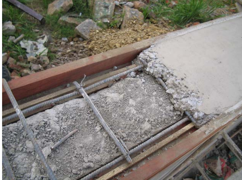
Fotografía 61. Se observa la formaleta para goteros y el refuerzo instalado.
