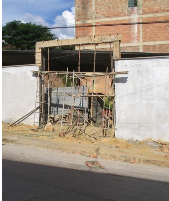
Fotografía 63. Formaleta armada lista para fundir.
