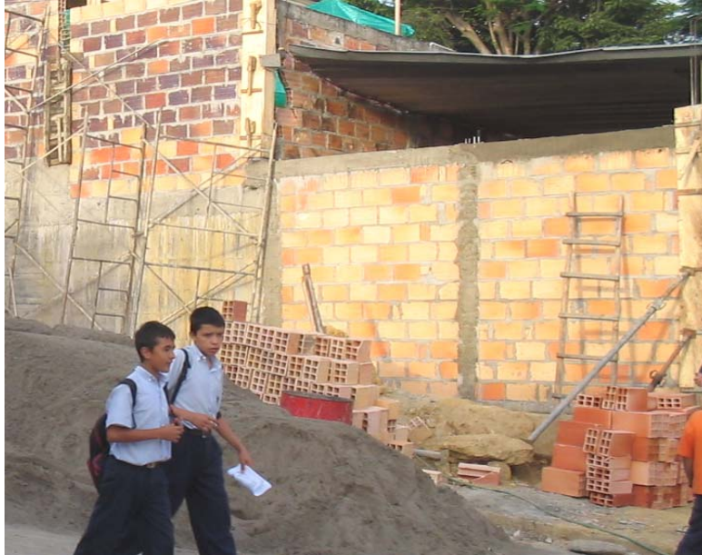
Fotografía 43. Vigueta fundida en conjunto con la columneta.
