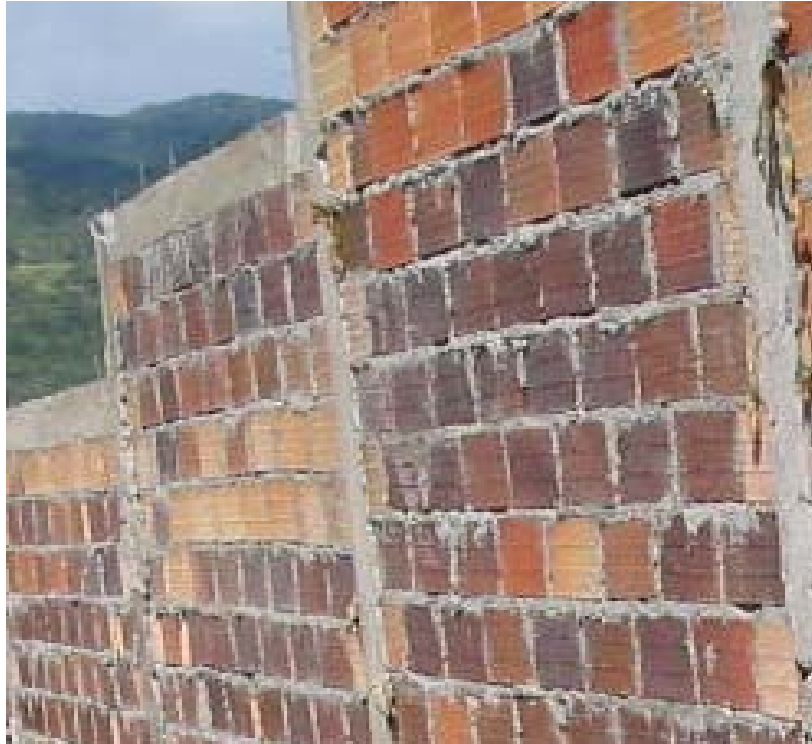
Fotografía 53. Columneta y vigueta de 15 x 20 cm, que confinan el muro.
