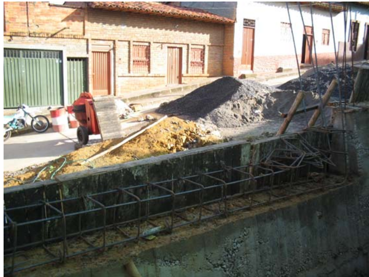
Fotografía 37. Detalle del refuerzo longitudinal y transversal de la viga cimentación.
