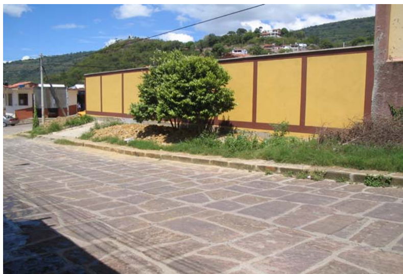
Fotografía 77. Pintura final de muro por la carrera sexta.
