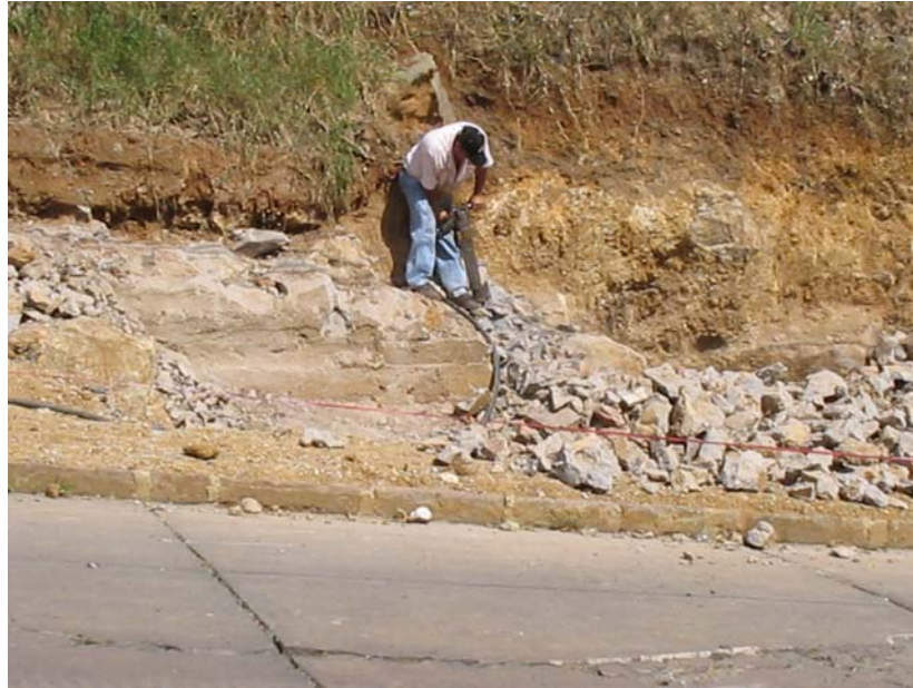
Fotografía 4. Demolición utilizando compresor y dos ayudantes.
