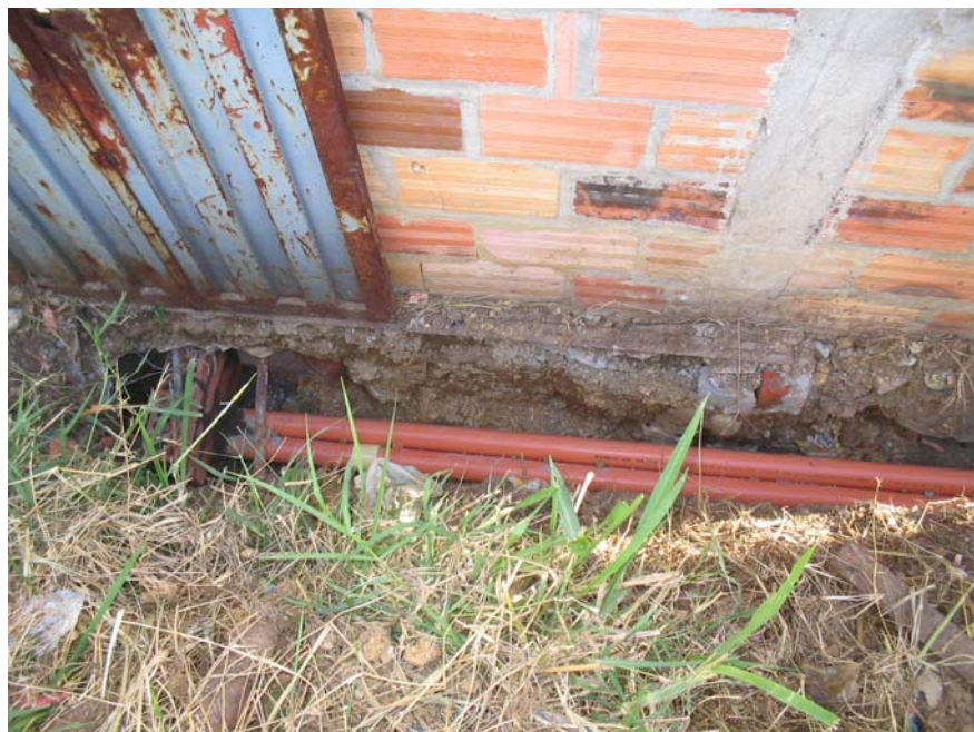
Fotografía 66. Instalación de tubería de 3".
