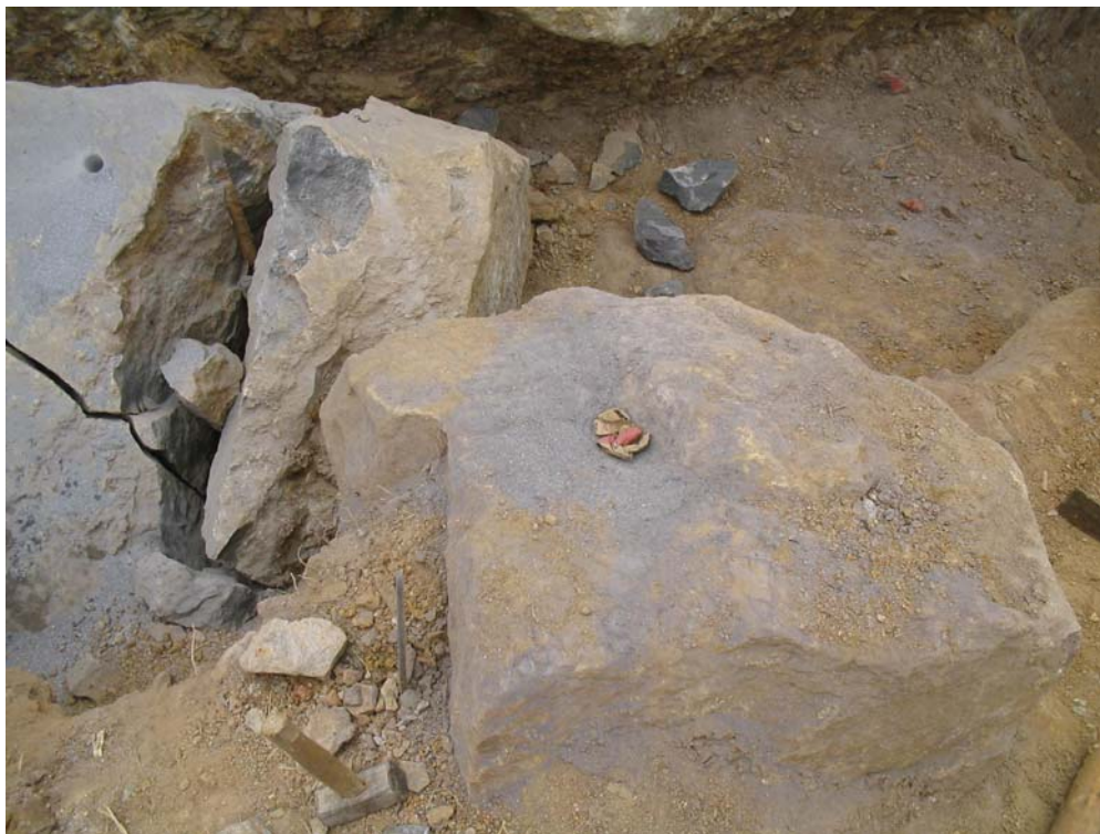
Fotografía 19. Rocas perforadas listas para la voladura.
