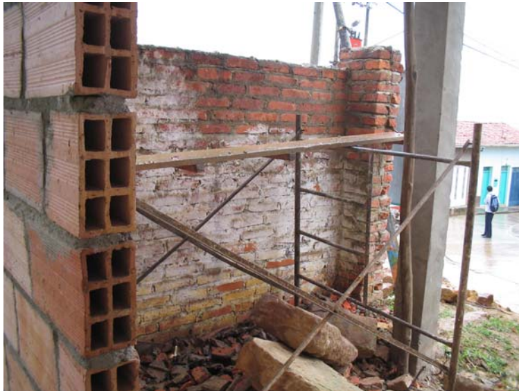
Fotografía 24. Se inicia por la demolición del ladrillo T1.
