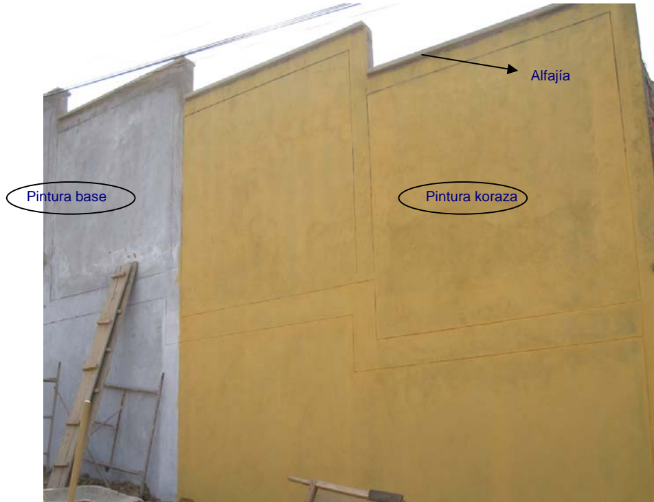
Fotografía 65. . Aplicación de la pintura koraza sobre la pintura base.
