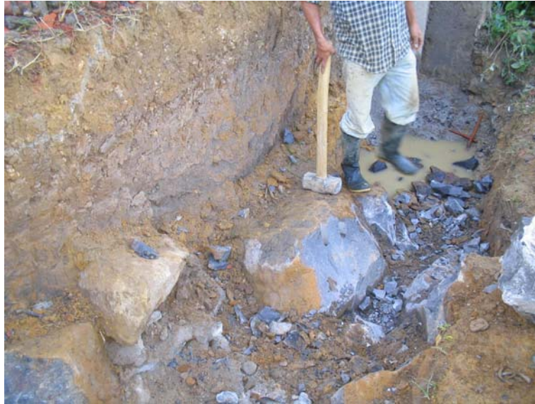
Fotografía 30. Excavación para fundir el muro de contención por la carrera 6ta.
