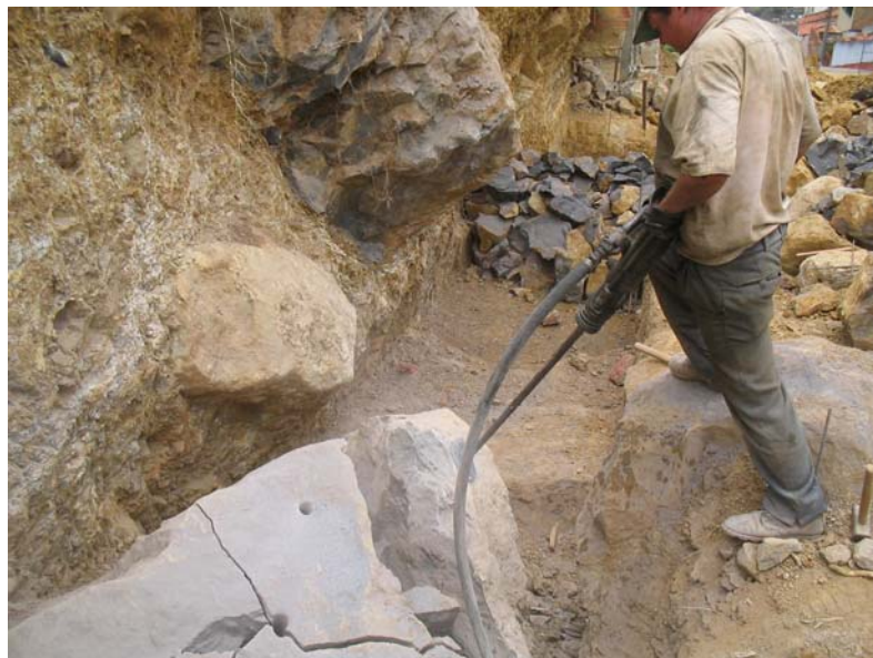
Fotografía 12. Se usó el compresor y explosivo para realizar la demolición de la roca.
