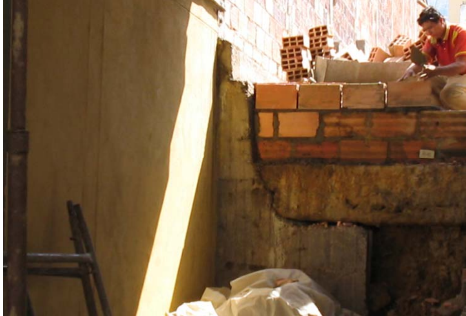
Fotografía 71. Reparación del área de mampostería en H-10.
