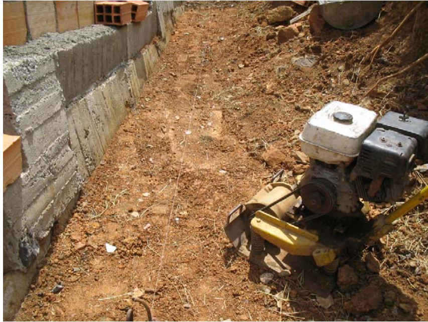
Fotografía 55. Capa de triturado inferior al concreto de la canaleta e instalación de la formaleta para su fundida.
