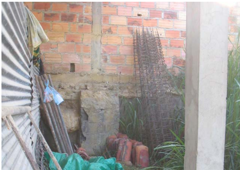
Fotografía 44. Refuerzo de viguetas y columnetas para su posterior colocación.
