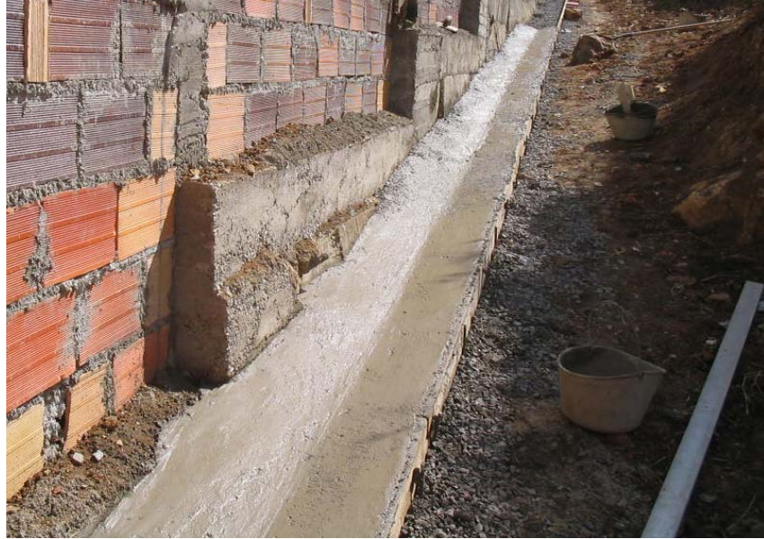
Fotografía 56. Fundición de la canaleta en un solo tramo.
