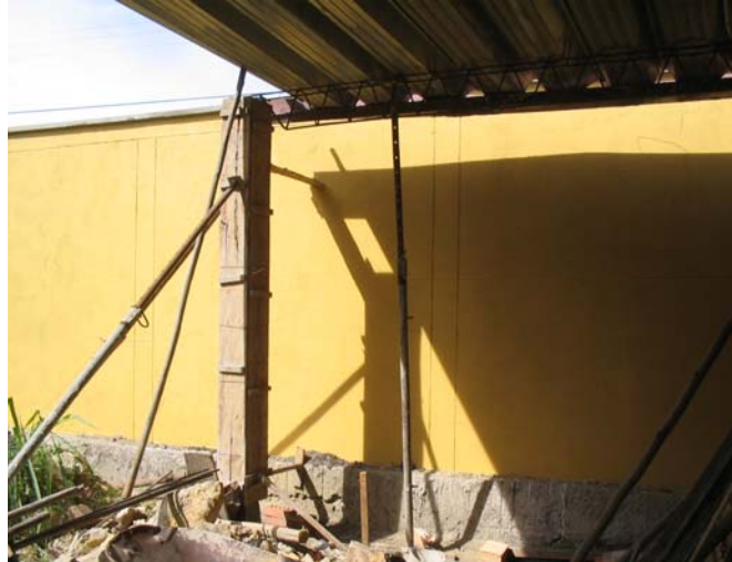
Fotografía 69. Columneta fundida.
