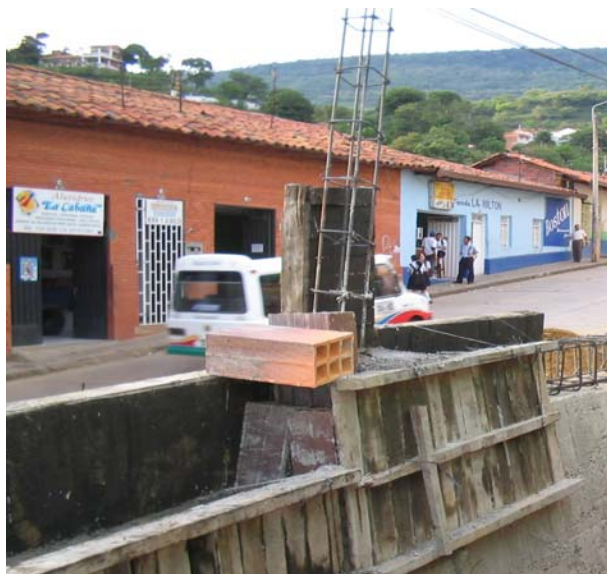
Fotografía 48. Estado posterior al retiro. La vía se vuelve a habilitar para la circulación de vehículos
