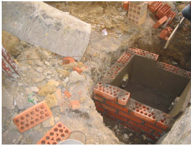
Fotografía 68. Caja de inspección que recoge aguas de la calle y del colegio.
