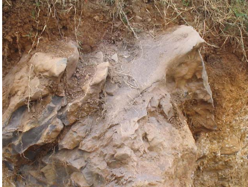
Fotografía 11. Se encontró material rocoso en el talud contiguo al cuerpo del muro a fundirse.
