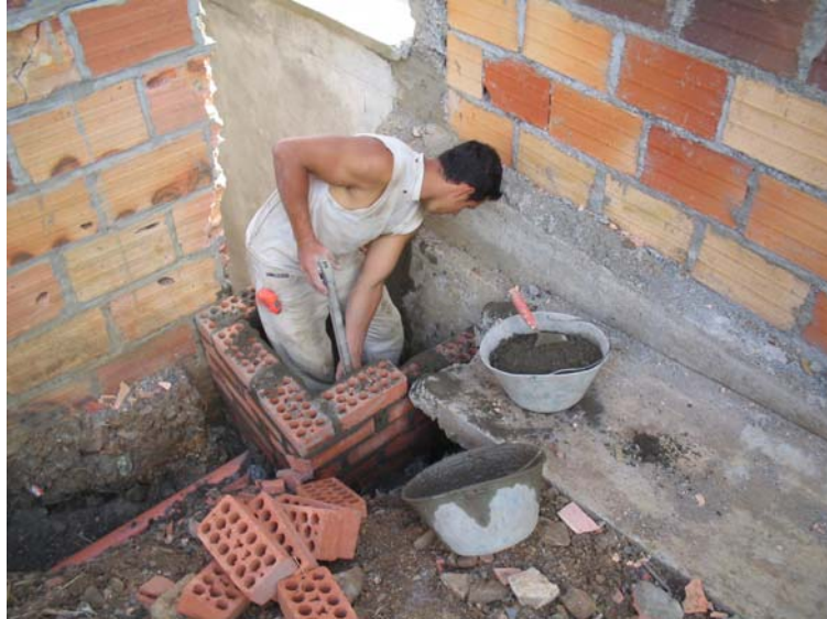
Fotografía 68. Caja de inspección que recoge aguas de la calle y del colegio.
