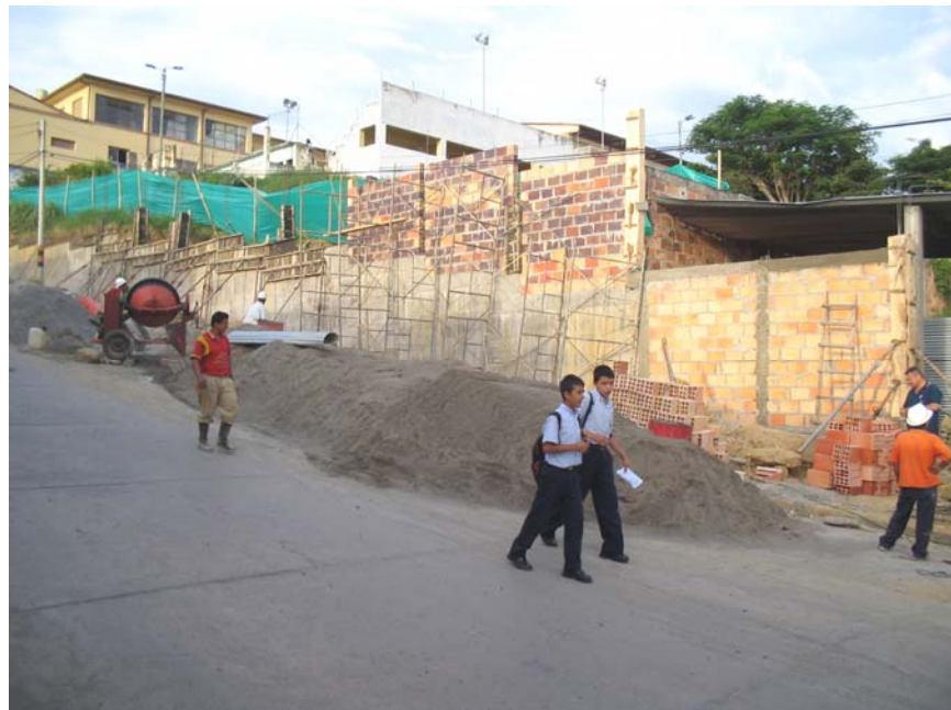
Fotografía 46. Levantamiento de mampostería por la calle 13.
