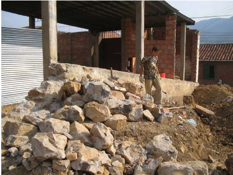
Figura 3. Sección de muro ciclópeo demolido mecánicamente.
