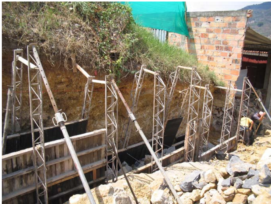
Fotografía 15. Armada de cerchas y tableros según el hilo rojo después de fundir zapatas.
