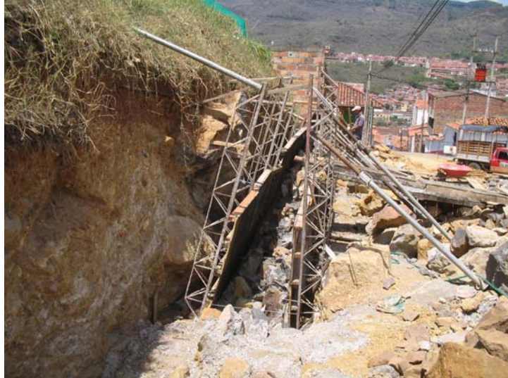
Fotografía 16. Colocación de la piedra rajón por capas después de amarrar cerchas y tableros.
