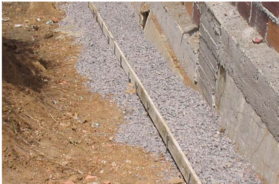
Fotografía 55. Capa de triturado inferior al concreto de la canaleta e instalación de la formaleta para su fundida.
