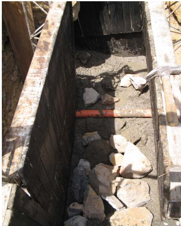
Fotografía 17. Lloraderos en tubo de tres pulgadas y tabla limitando los tres metros.
