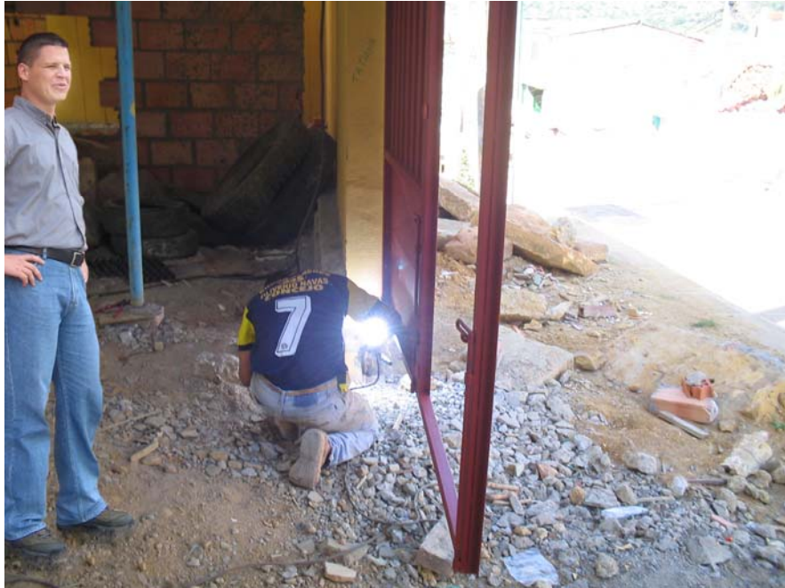
Fotografía 76. Portón instalado por la calle 13 en el acceso al parqueadero.
