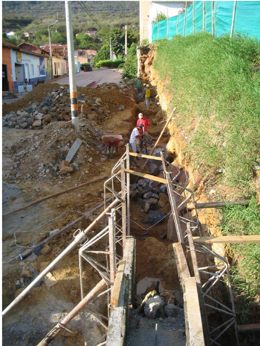
Fotografía 18. Tramo de excavación en planta y corte del talud.
