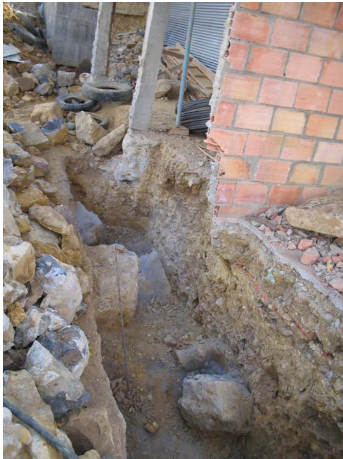
Fotografía 29. Excavación en el tramo largo del parqueadero.
