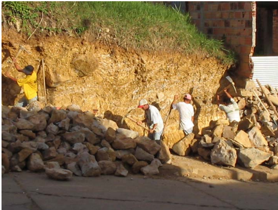
Fotografía 8. Excavación de módulos.
