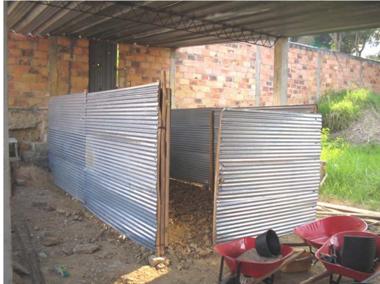
Fotografía 1. Detalle del campamento ubicado dentro de las instalaciones del colegio Guanentá.
