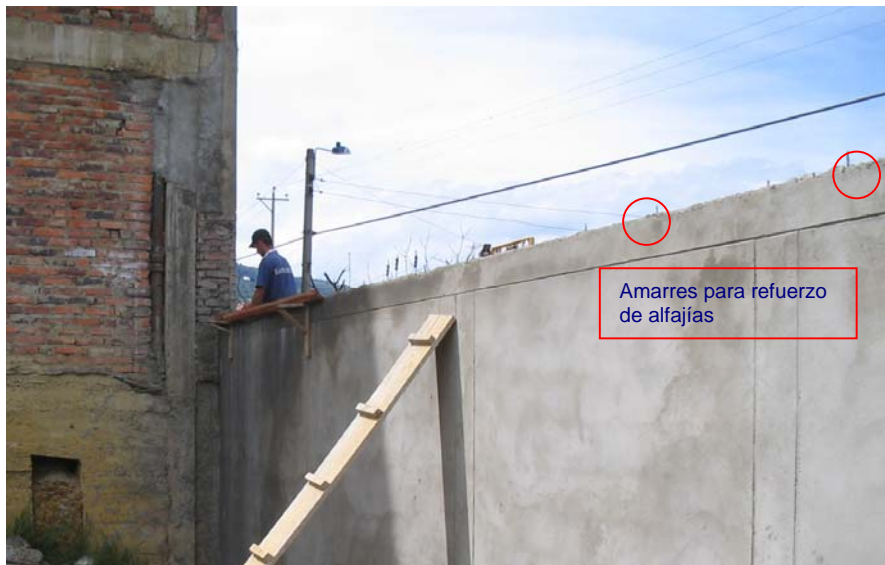
Fotografía 60. Formaleta para alfajías con unos pines en varilla dejados en la vigueta para amarrar el refuerzo.
