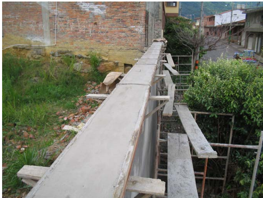
Fotografía 62. Construcción de alfajía usando reglas en madera tolúa de gran resistencia
