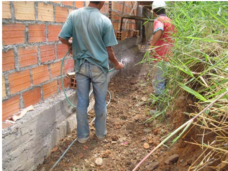
Fotografía 54. Adecuación del terreno y compactación del mismo en la zona de construcción de la canaleta
