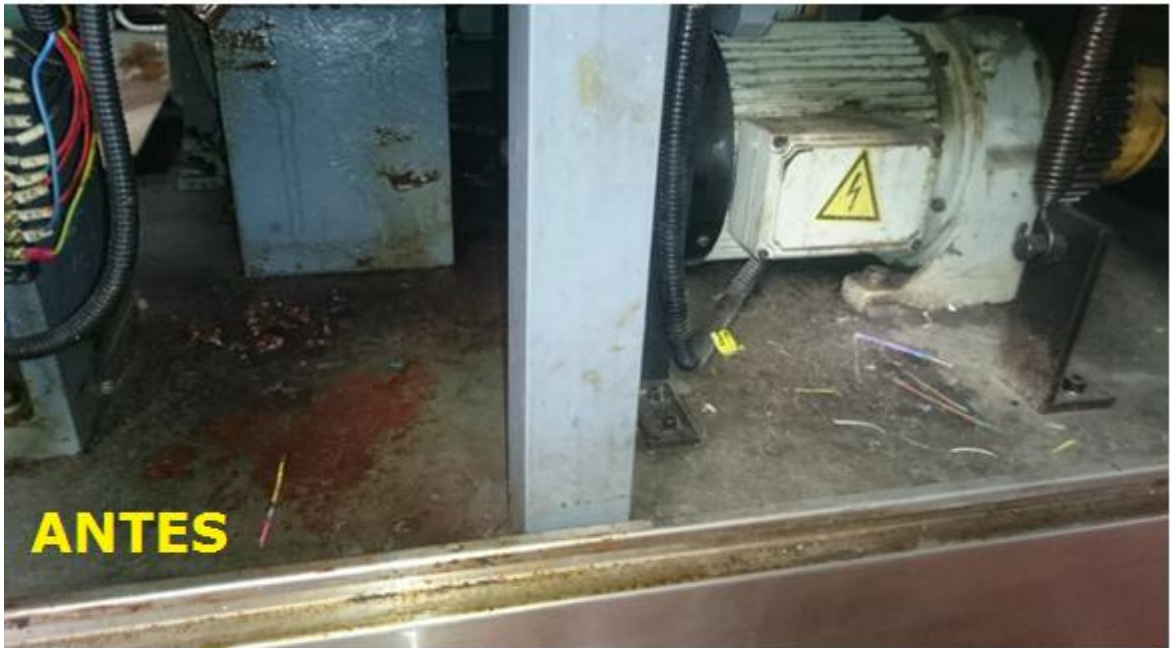
Figura 68. Limpieza zona motor eléctrico
