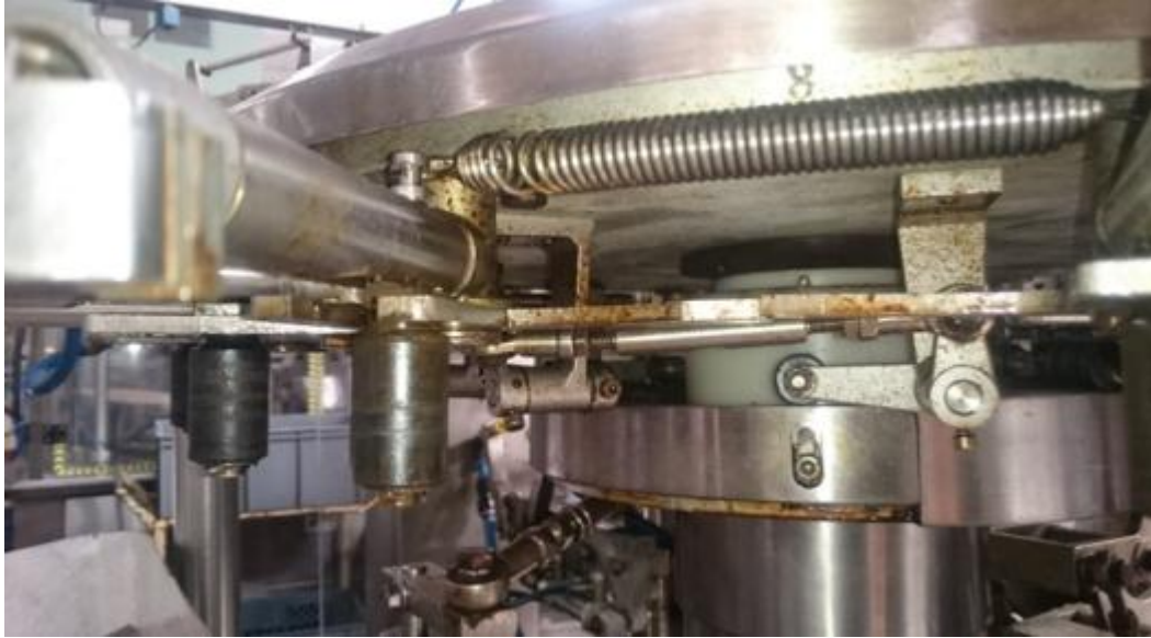
Figura 62. Resorte dañado y piezas con oxidación
