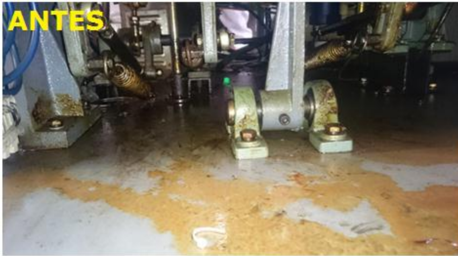
Figura 67. Limpieza de lubricante y corrección de fugas
