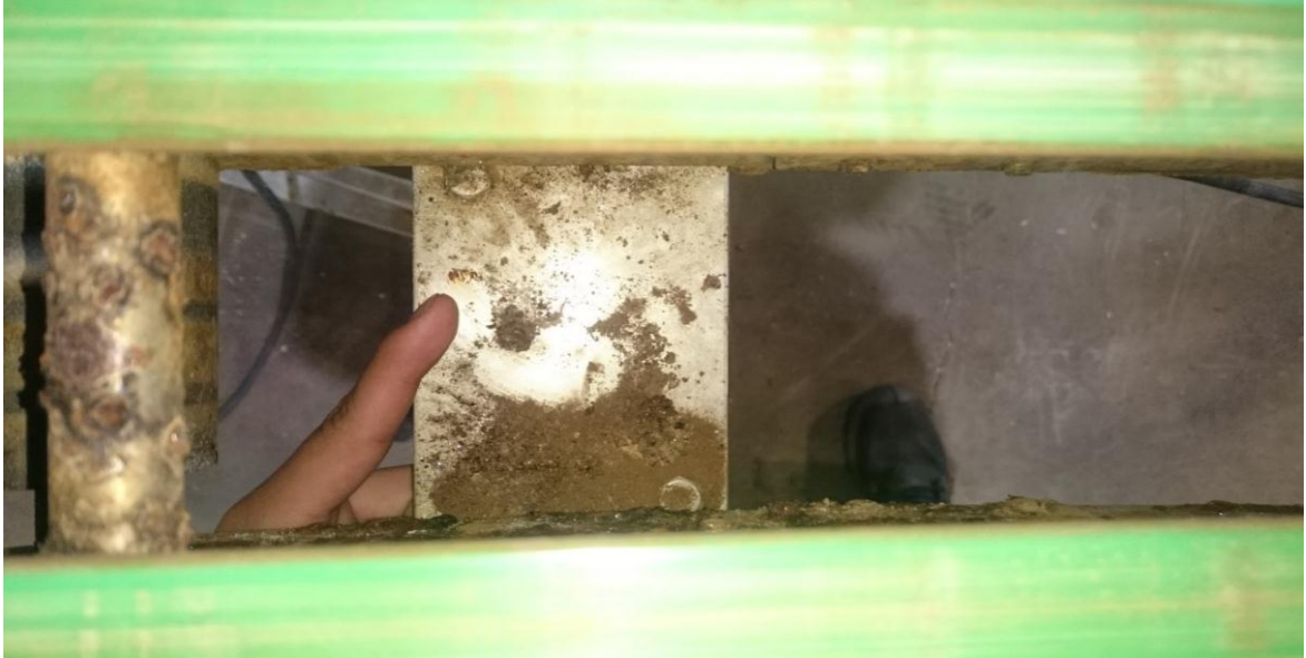
Figura 41. Acumulación de suciedad en distanciadores de bandas.
