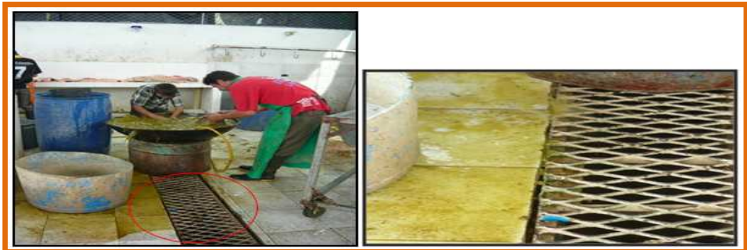
Fotografía No. 12 Canal de recolección de aguas residuales.
