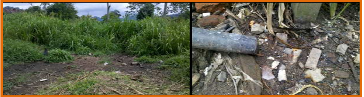
Fotografía No. 17 Vertimiento de lodos a campo abierto.
