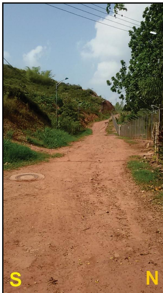
Figura 10. Suelo de relleno, vía que comunica al Barrio Bariloche II Etapa con el Monumento a La Virgen.
