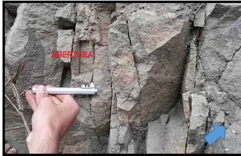
Figura 18. Ejemplo de medición de las aberturas de las discontinuidades por medio de un calibrador.
