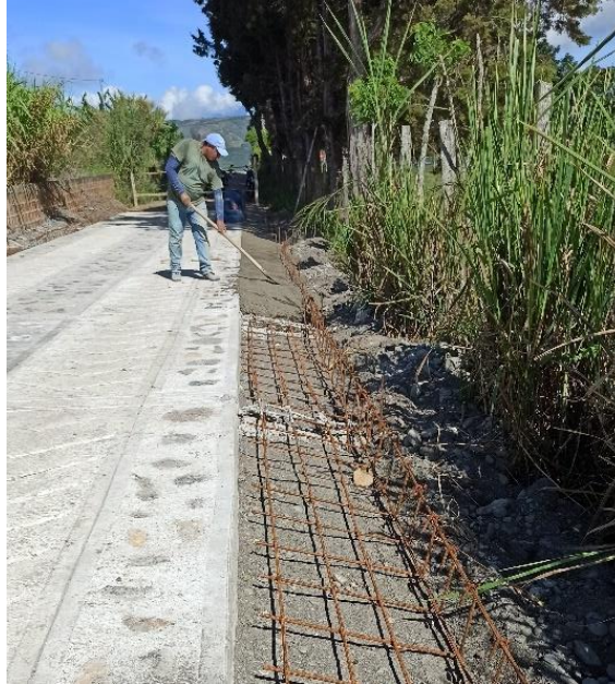
Figura 12. Refuerzo de bordillo y Berma-cuneta en la vereda los pozos en el municipio de San Gil, Santander.(fuente propia)
