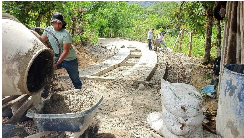
Figura 4. Preparación de concreto en la vereda Boqueron en San Gil, Santander.(fuente propia)
