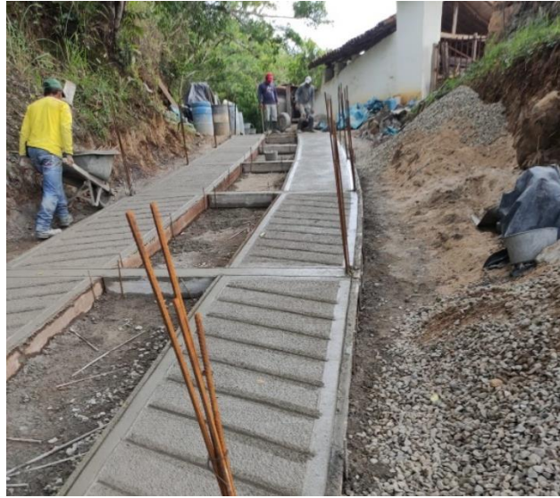
Figura 13. Fundición de franjas de huella y vigas riostra en la vereda el Tabor en el municipio de San Gil, Santander.(fuente propia)
