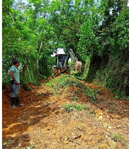
Figura 5. Conformación de la calzada en la vereda Boqueron del municipio de San gil, Santander. (fuente Propia)
