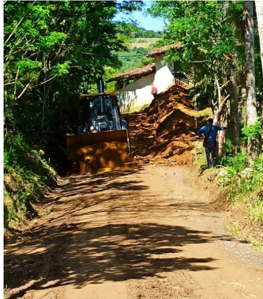
Figura 6. Excavación mecánica en material común en la vereda el Tabor en San Gil, Santander.(fuente propia)
