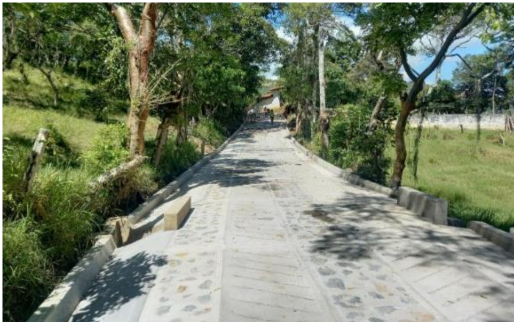
Figura 1. Placa huella Construida por Consorcio VYP Vías Santander en la vereda El Tabor en San gil, Santander.(fuente propia)
