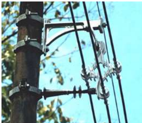
Figura 1. Montaje de fijación al poste
