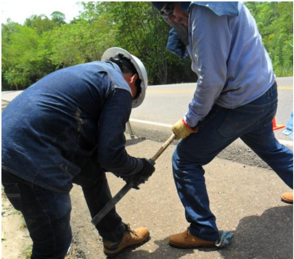
Foto 15. Retiro de un núcleo atascado, siendo empujado con una vara de madera.
