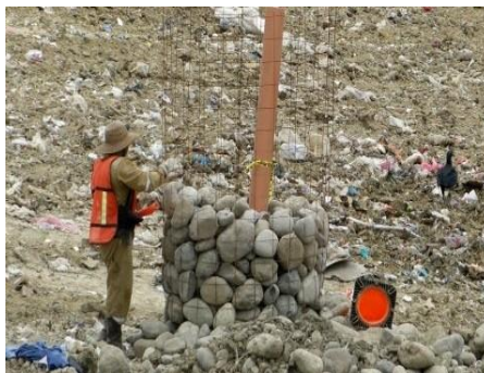
Figura 8: Construcción de pozos (drenaje pasivo)
