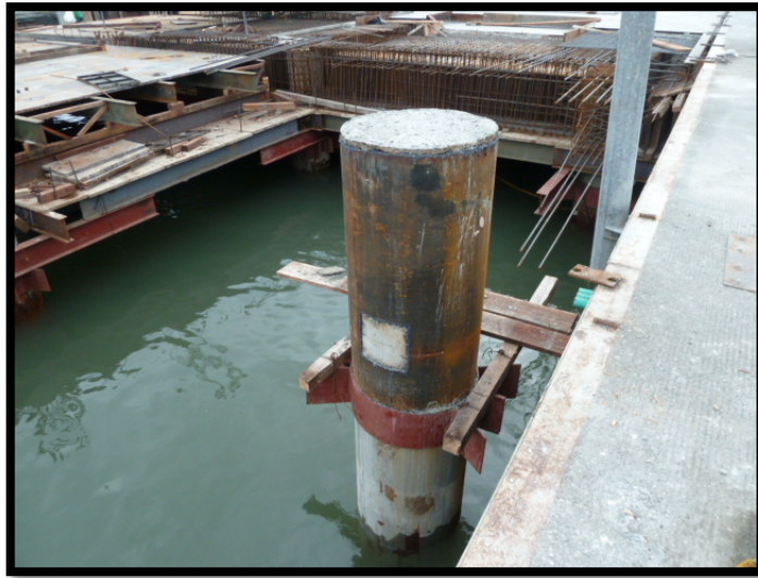
Imagen 26. Realce en la cabeza del pilote.
