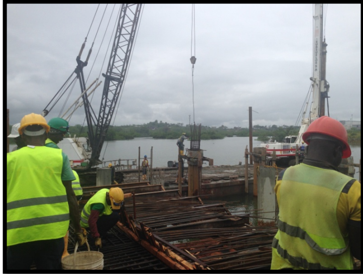
Imagen 22. Instalación del acero de refuerzo.
