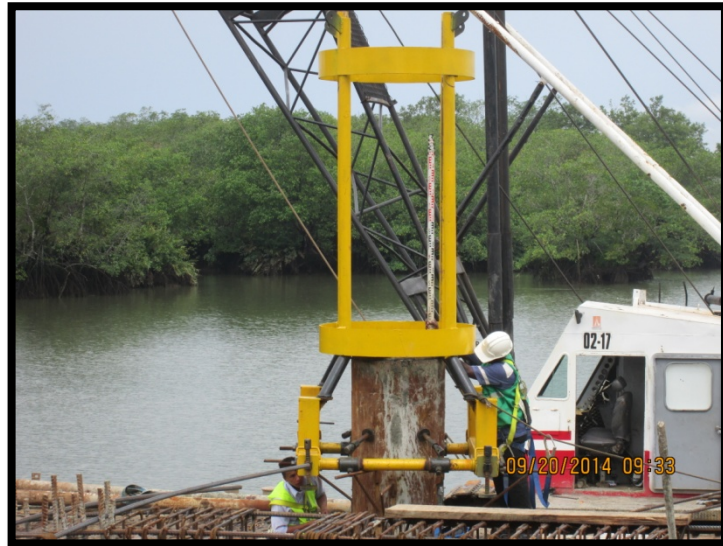
Imagen 29. Control del asentamiento del pilote.
