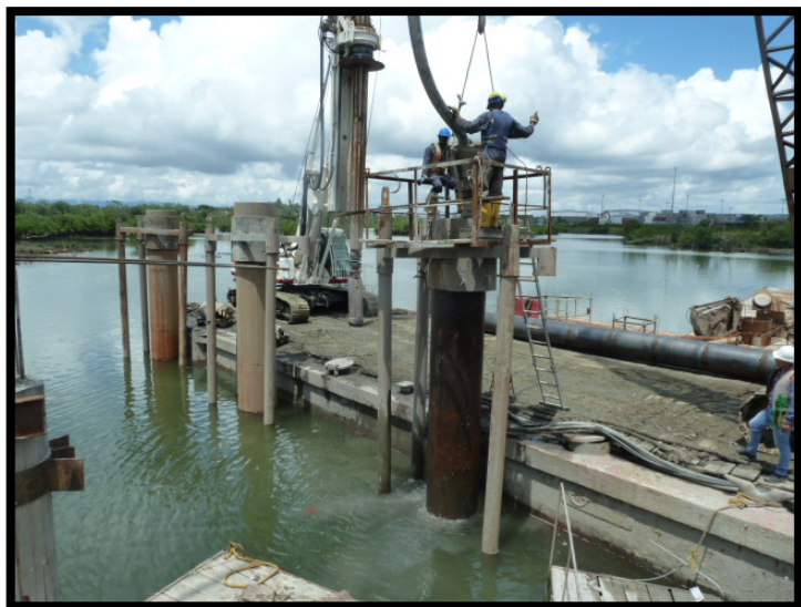
Imagen 23. Colocación de concreto en la excavación.
