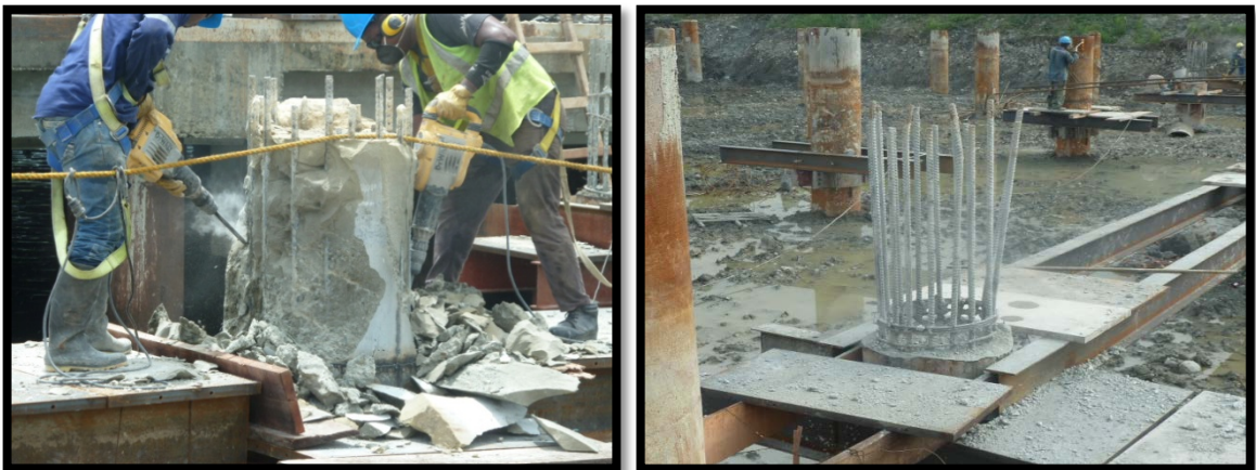
Imagen 25. Descabece del pilote.
