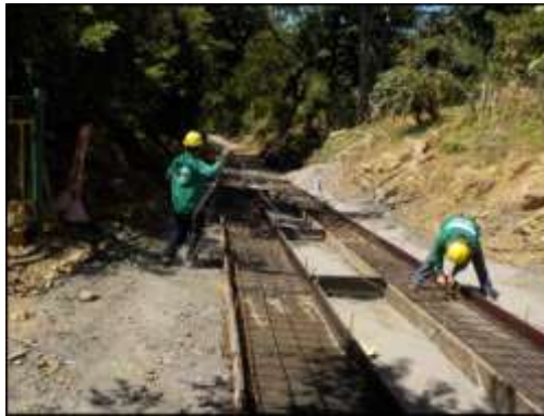
Figura 13. Seguimiento en instalación de acero de refuerzo en vigas y losa de pavimento.
