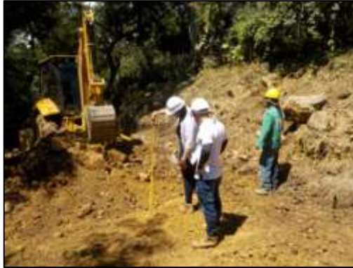
Figura 10. Seguimiento en la actividad de excavación y replanteo de subrasante
