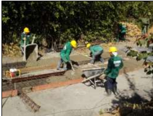
Figura 14. Seguimiento en proceso de fundición de losas de pavimento.
