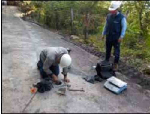
Figura 12. Seguimiento del ensayo humedad optima en compactación en sub-base compactada.
