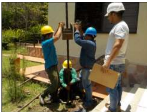
Figura 3. Ejecución del ensayo (SPT)
