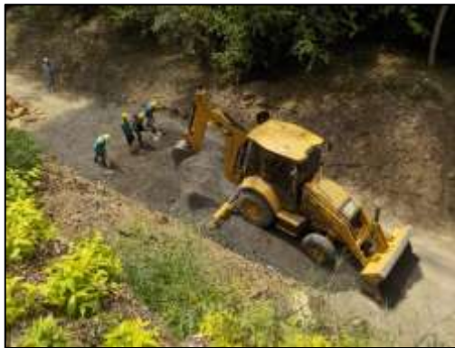
Figura 11. Seguimiento en la actividad de extendido del material granular
