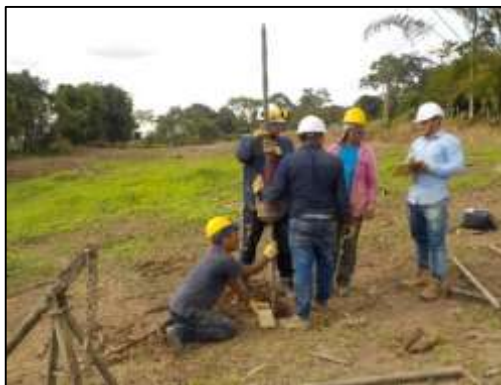
Figura 6. Ejecución del ensayo (SPT)
