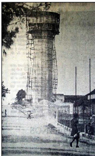
Fotografía 8. Construcción del tanque del acueducto de La Cumbre.
