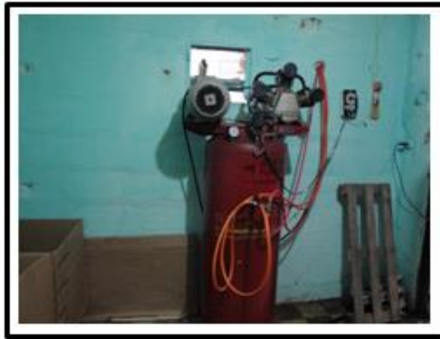
Ilustración 24. Bodega 2 vista lateral derecha
