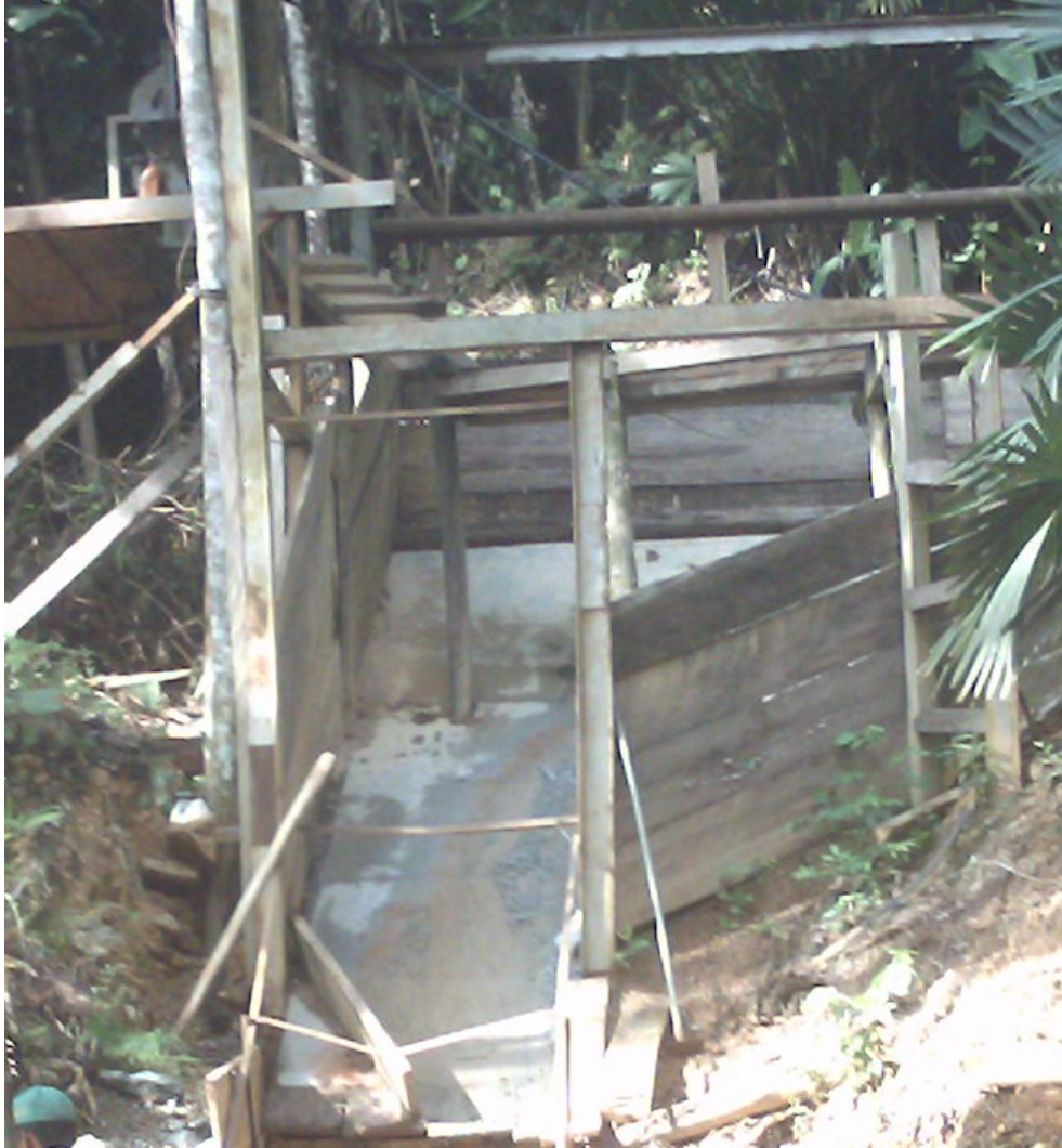
Figura 23. Zona de descargue de material capacidad 35 ton mineral fresco.
