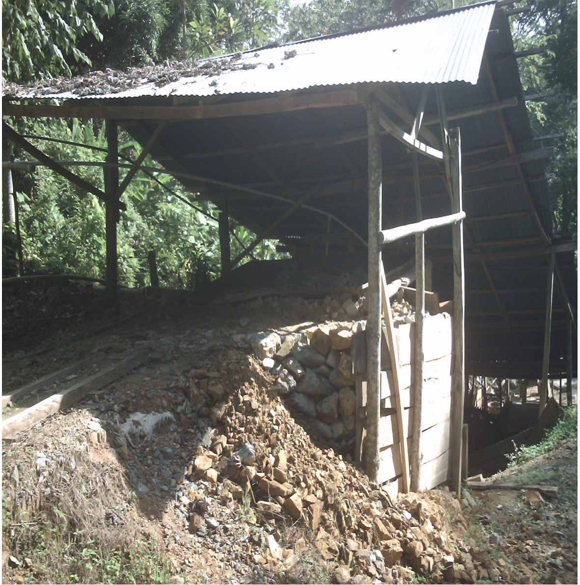
Figura 24. Tolva de cargue de mineral a la planta. Capacidad 16 ton.
