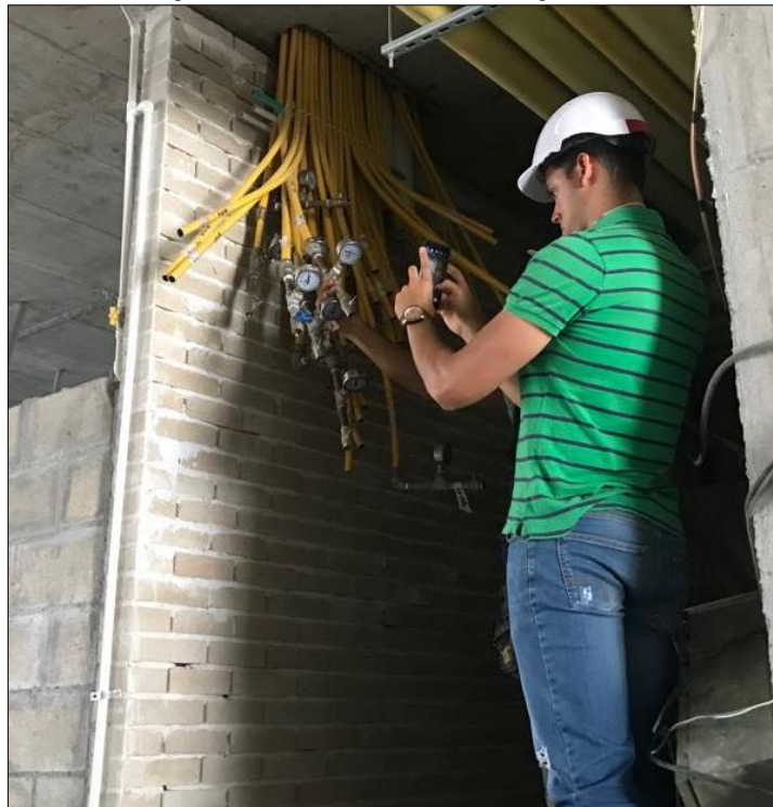
Figura 13 Registro fotográfico seguimiento y control prueba de presión de red de gas apartamento, punto fijo y acometida vertical. Fuente: Supervisión técnica independiente.
