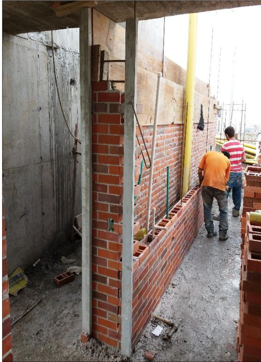
Figura 39 Avance en el proceso de instalación mampostería en limpio BBQ zona social, muro con vigueta.
