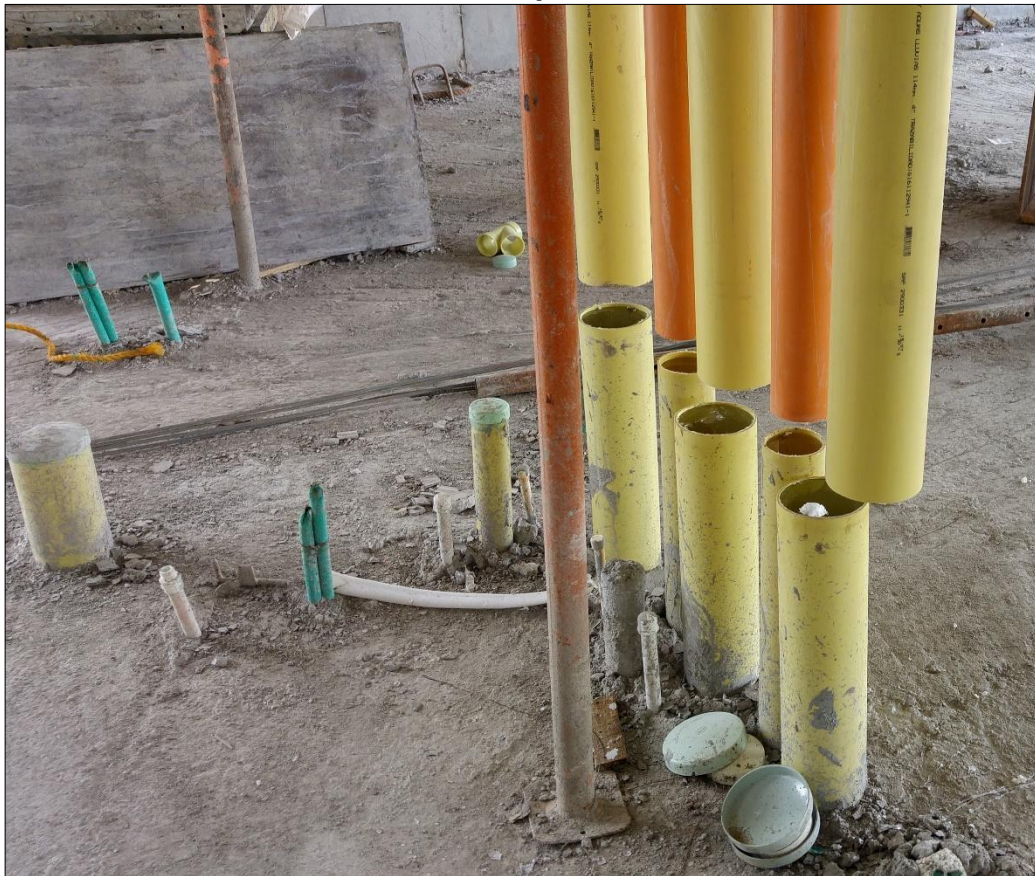
Figura 14 Registro fotográfico del seguimiento y control de la prueba de estanqueidad.
