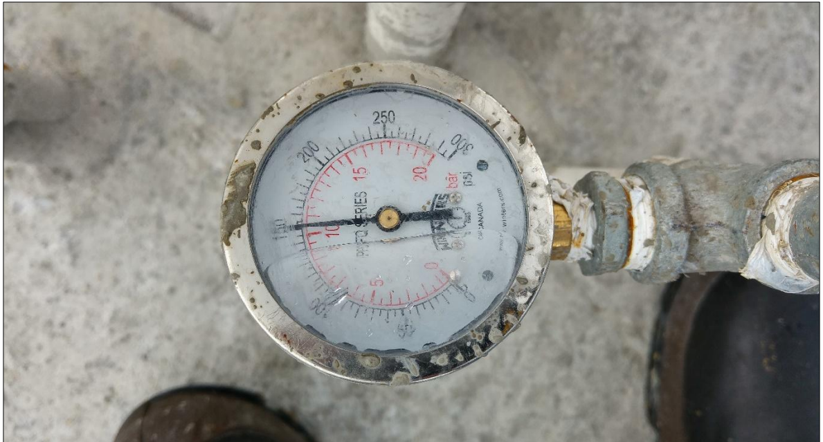
Figura 11 Registro fotográfico del seguimiento y control de la prueba hidráulica de presión después de la fundida.
