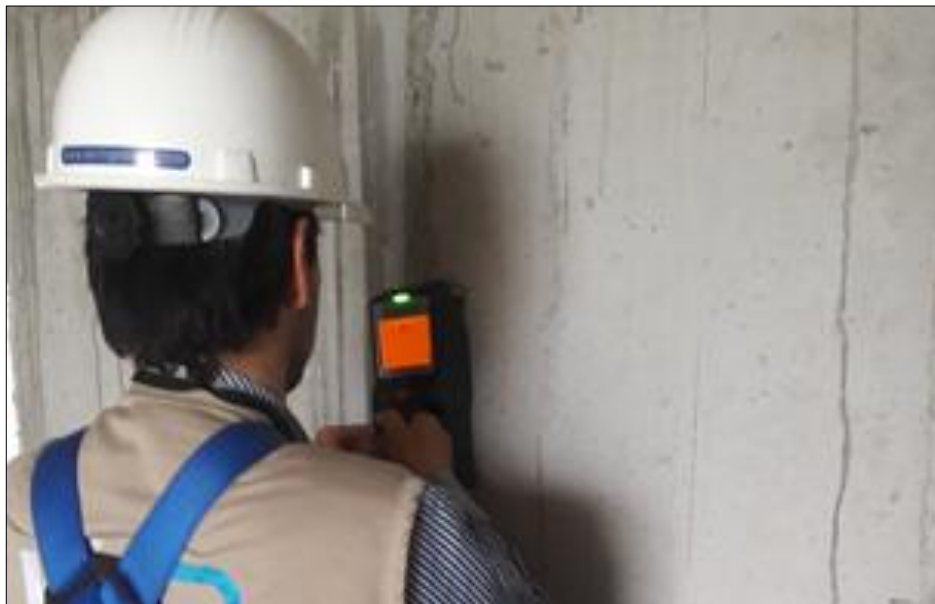
Figura 23 Escaneo del acero en muro estructural ensayo no destructivo de esclerometría.
