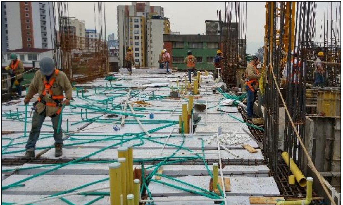
Figura 9 Supervisión en la instalación de redes eléctricas e hidrosanitarias N+15,80.
