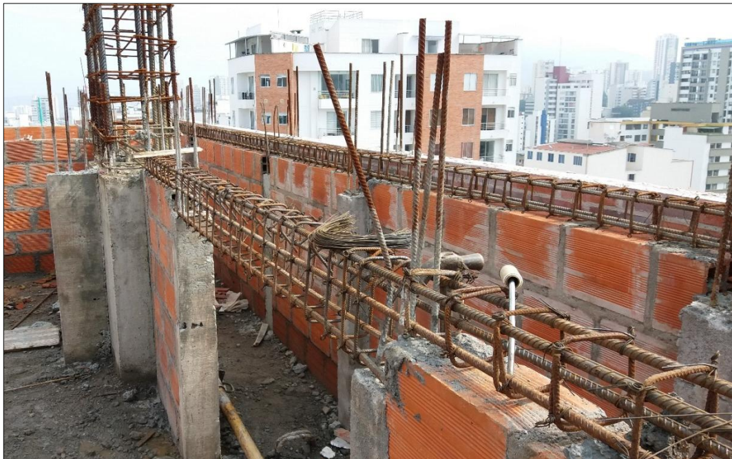
Figura 31 Avance en el proceso mampostería confinada y armado de acero placa maciza zonas húmedas.
