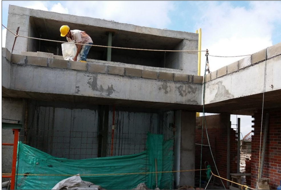
Figura 40 Avance en el proceso de instalación bloque de cemento, bordillo de cubierta.
