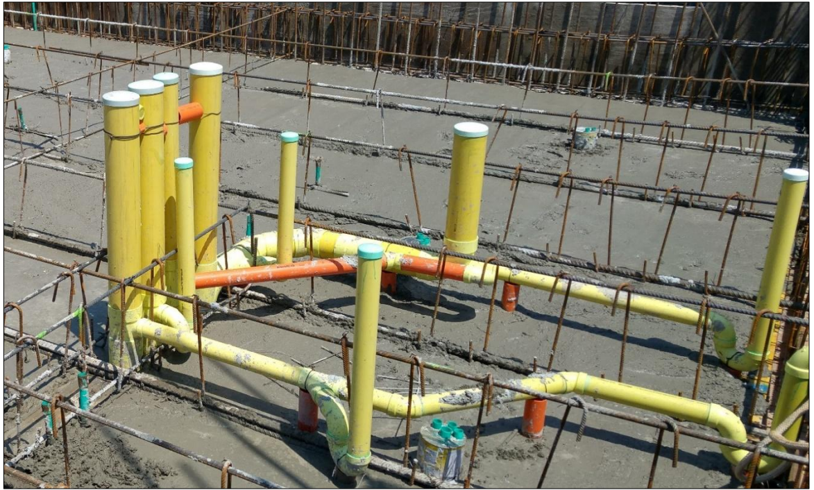
Figura 8 Supervisión en la instalación de redes sanitarias en placa.
