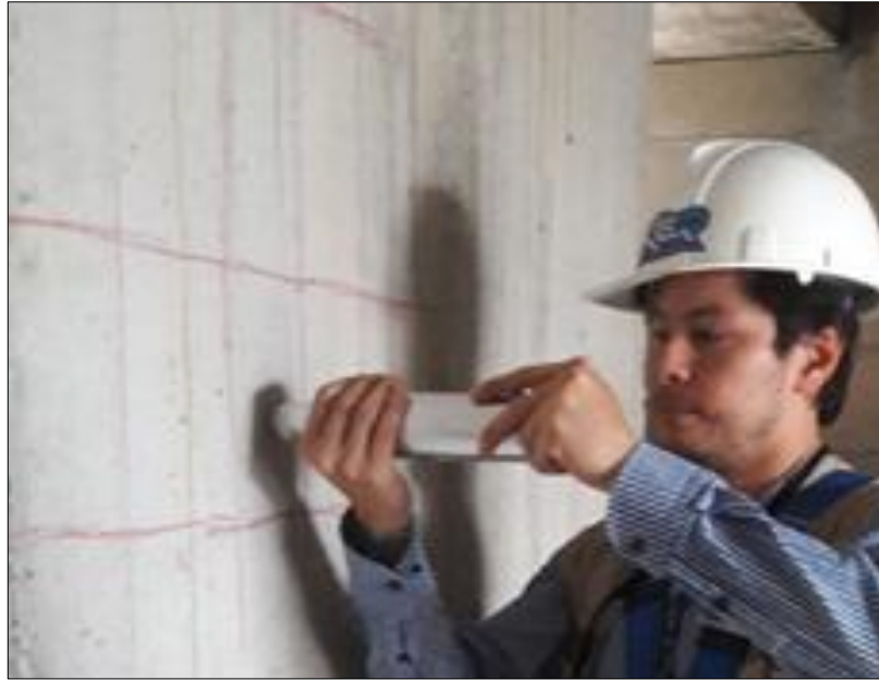
Figura 24 Ejecución del ensayo no destructivo de esclerometría con un ángulo de 0° con la horizontal y en zonas excluyentes de acero.
