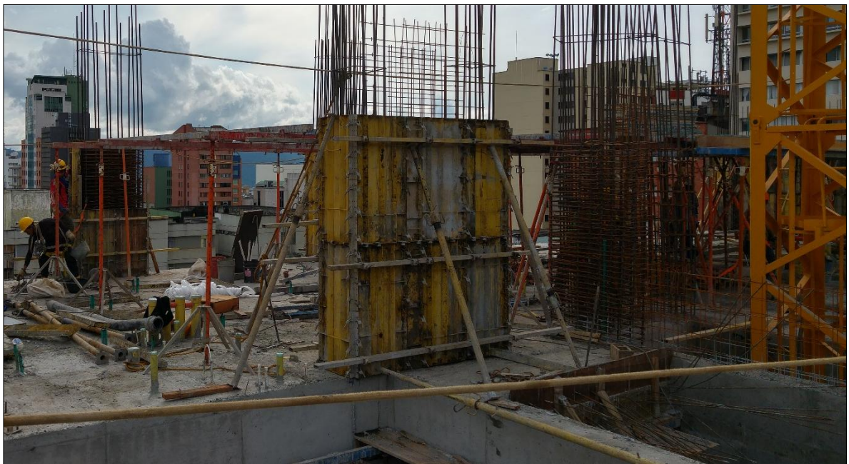
Figura 19 Armada de formaleta Encofrado de muro estructural y columna.
