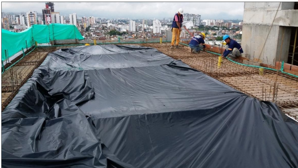
Figura 36 Avance en el proceso de armado de placa maciza e instalaciones hidrosanitarias y eléctricas.
