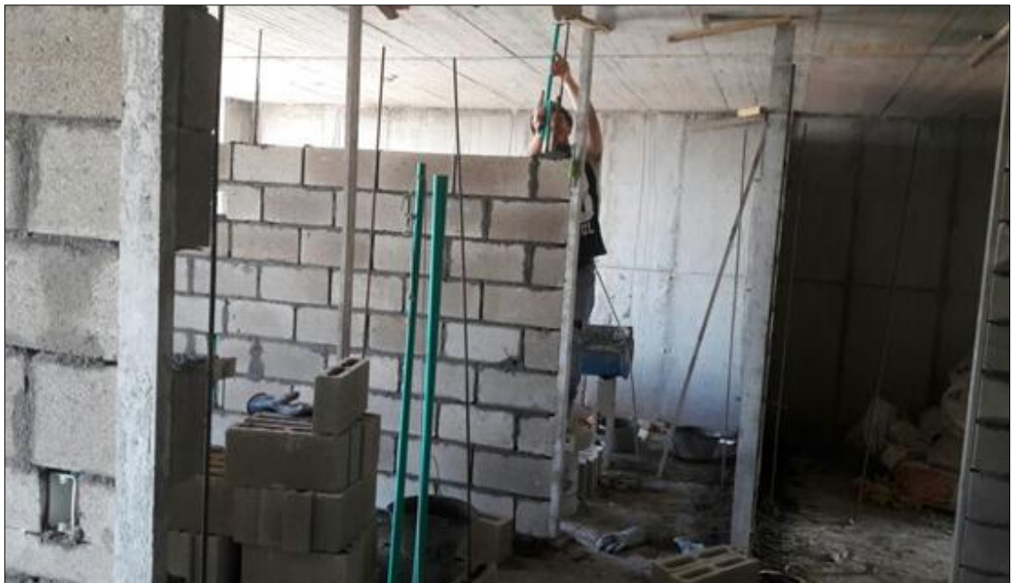
Figura 28 Avance en el proceso de mampostería correspondiente al apartamento 903. Se verifica dovelas, plomos y alineación de los muros.
