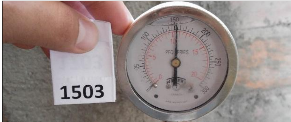
Figura 12 Registro fotográfico del seguimiento y control prueba hidráulica apartamentos.
