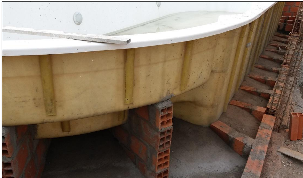
Figura 34 Avance en instalación de concreto pobre para confinar el colchón de arena.
