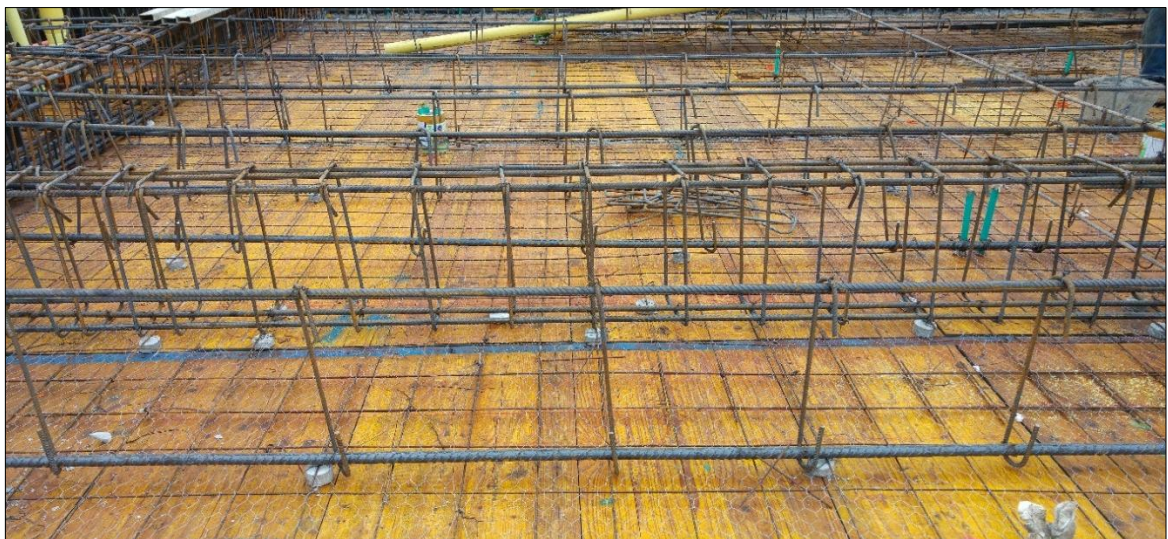
Figura 20 Distanciadores para garantizar el recubrimiento.
