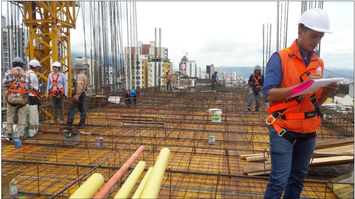
Figura 7 Supervisión en el armado del acero. Fuente: Supervisión técnica independiente.
