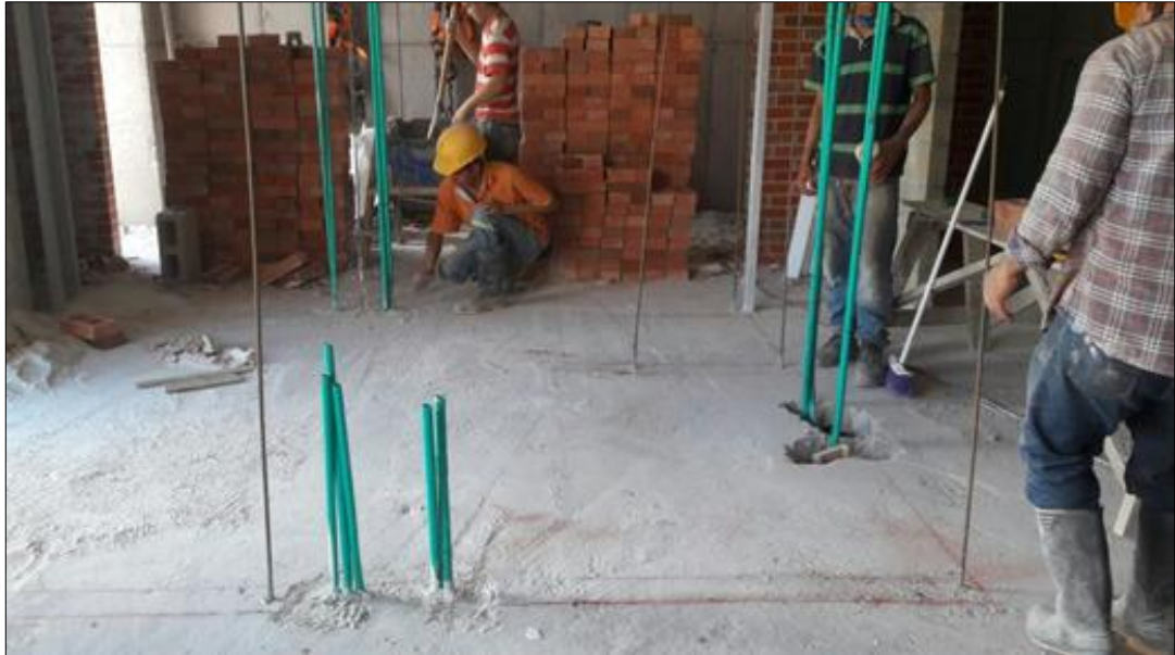
Figura 27 Avance en el replanteo y construcción de muros de mampostería correspondientes al apartamento 706.
