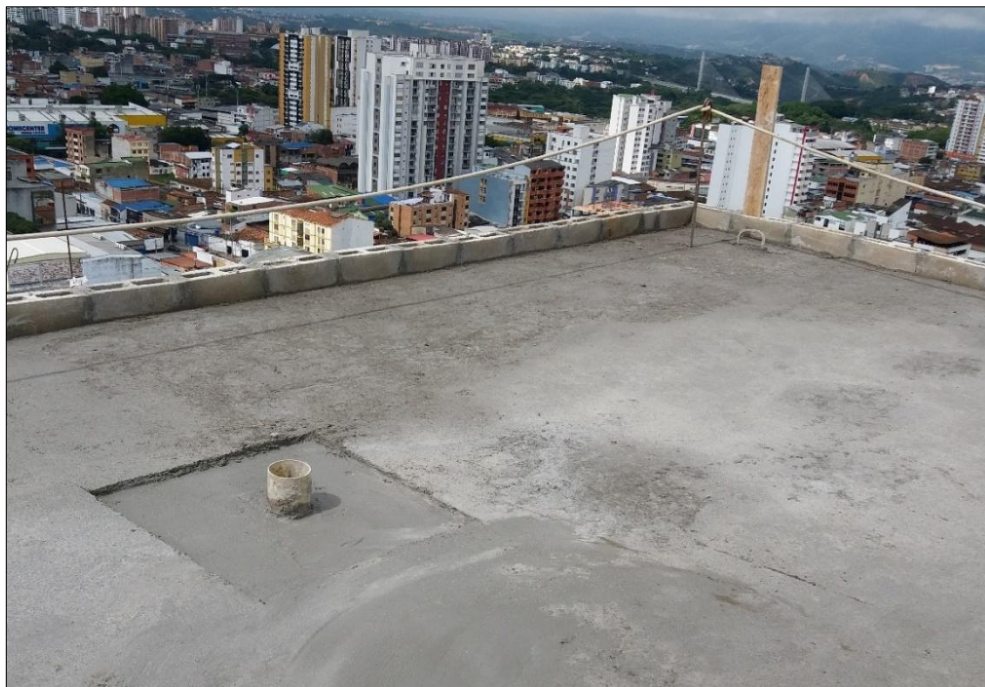
Figura 41 Avance en el proceso de instalación de mortero en la cubierta del gimnasio, y el bordillo con bloque de cemento.
