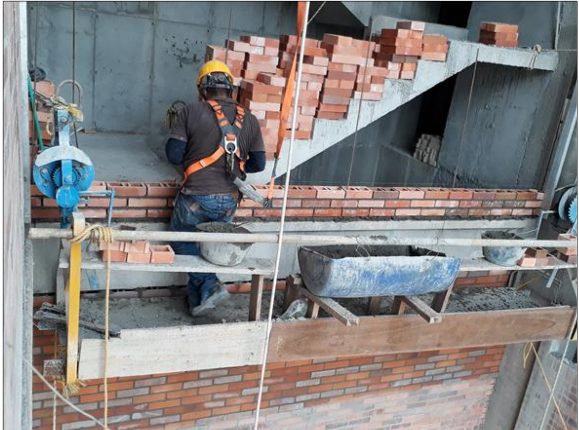
Figura 29 Avance en el proceso de mampostería de vacío interno correspondiente al punto fijo comprendido entre ejes B-C y 2-3 del piso 6.
