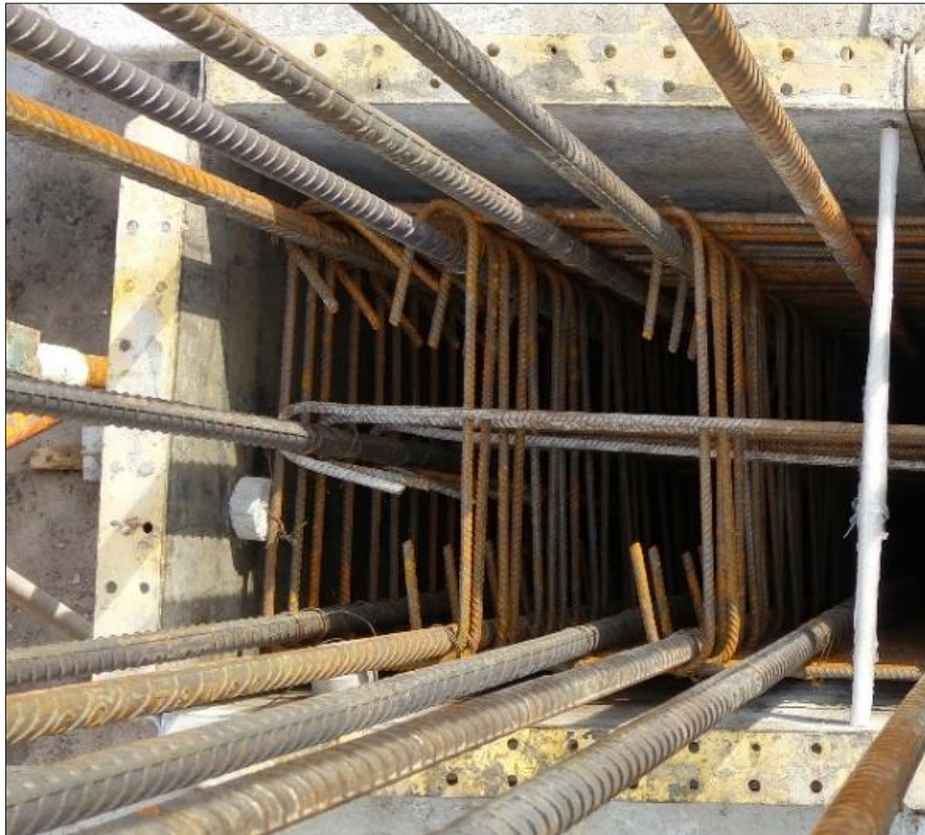
Figura 21 Registro del proceso de encofrado de una columna con sus distanciadores y corbatas.
