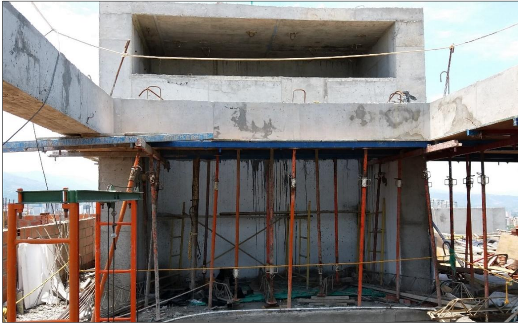
Figura 35 Avance en el proceso estructural cubierta gimnasio, sobre recorrido ascensores y cubierta ascensores.
