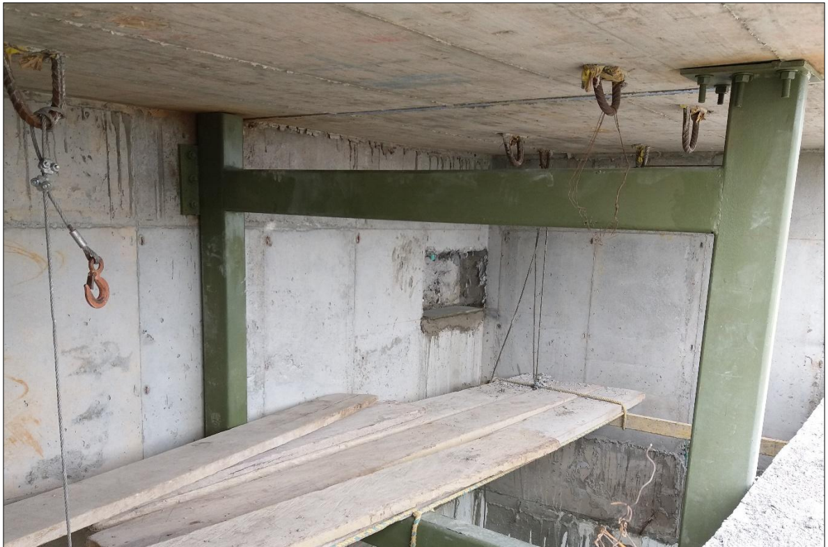
Figura 38 Avance en el proceso de instalación estructura metálica ascensores.
