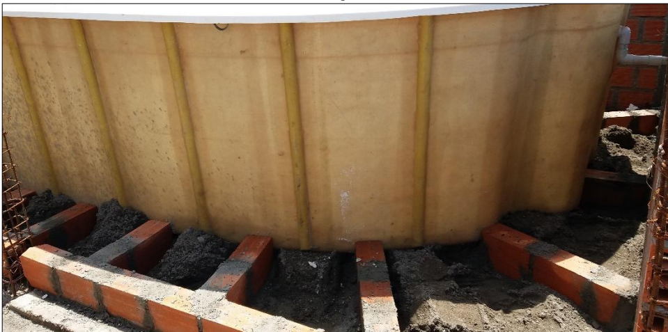
Figura 33 Avance en el proceso de mampostería confinada de la hidropiscina.
