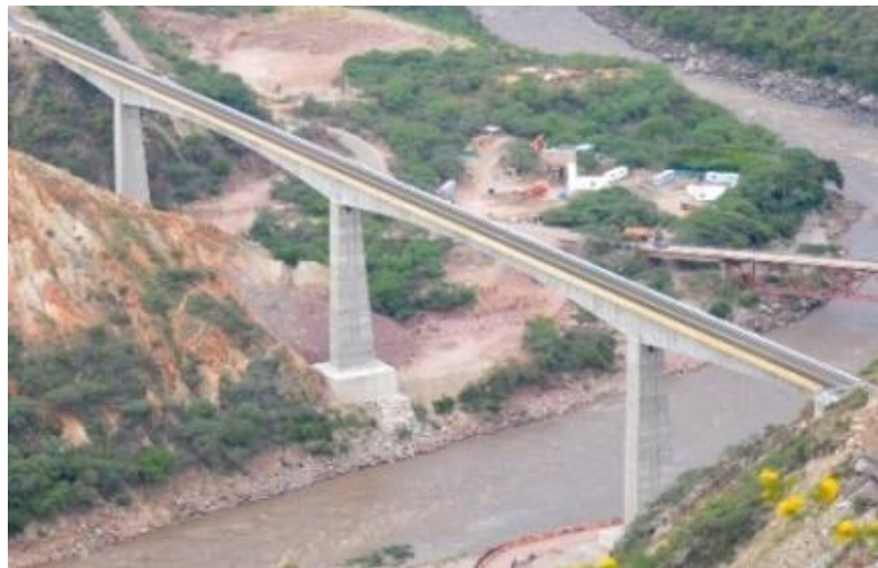
Figura 5. Nuevo Puente Gómez Ortiz.
