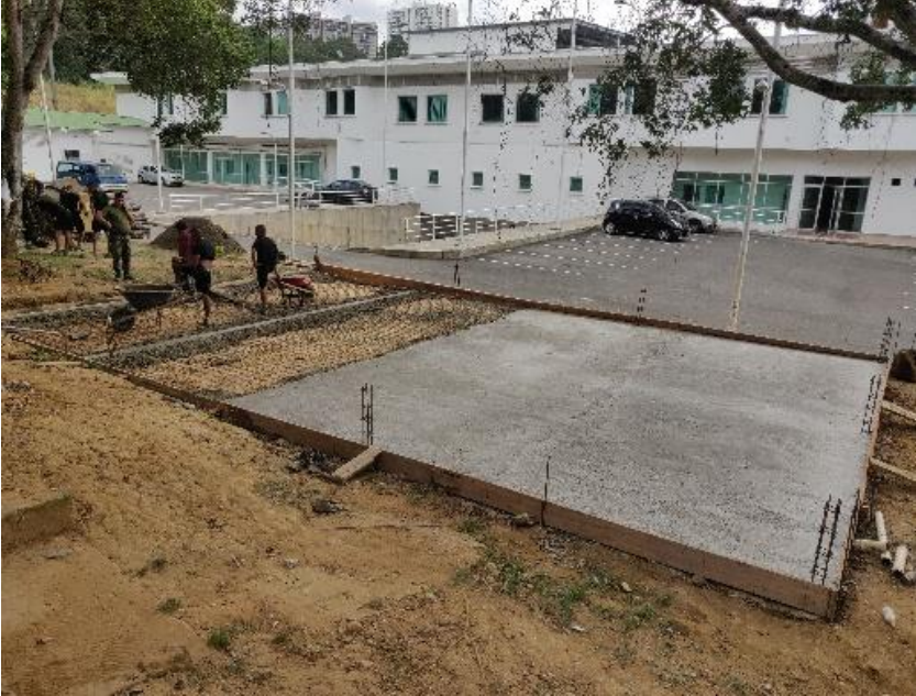
Figura 19. Avance de obra.
