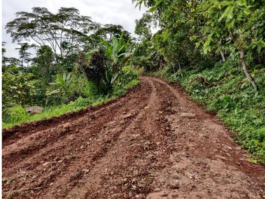
Figura 11. Muchos tramos de la vía requerían ampliación de la calzada.
