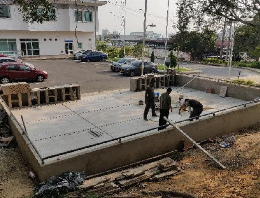
Figura 20. Avance de obra
