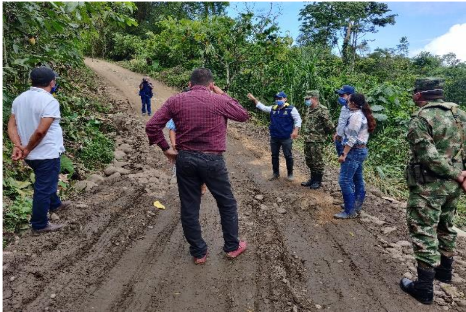
Figura 10. Se presentaban problemas de inestabilidad por infiltración de agua.
