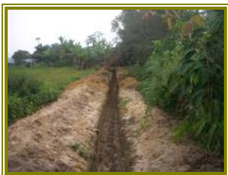
Imagen 21 y 22 Canales para red de alcantarillado, Alcantarillado Palmeras de Yariguies, San Vicente
