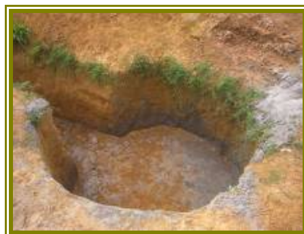
Imagen 19 y 20 Zanjas de Pozos de Inspección, Alcantarillado Palmeras de Yariguies, San Vicente
