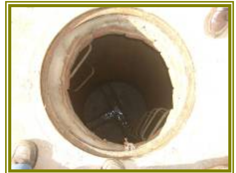
Imagen 31 Evacuación de agua en primer pozo
