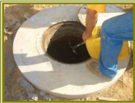
Imagen 30 Descarga de agua en primer pozo
