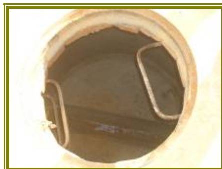
Imagen 32 Llegada de agua en segundo pozo
