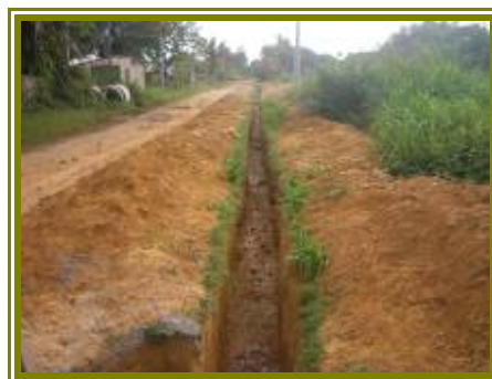
Imagen 21 y 22 Canales para red de alcantarillado, Alcantarillado Palmeras de Yariguies, San Vicente
