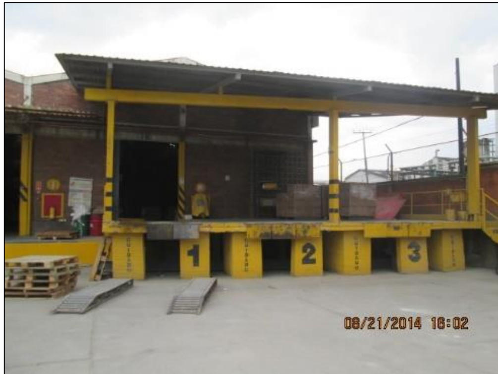
Imagen 1. Área de recepción 1
