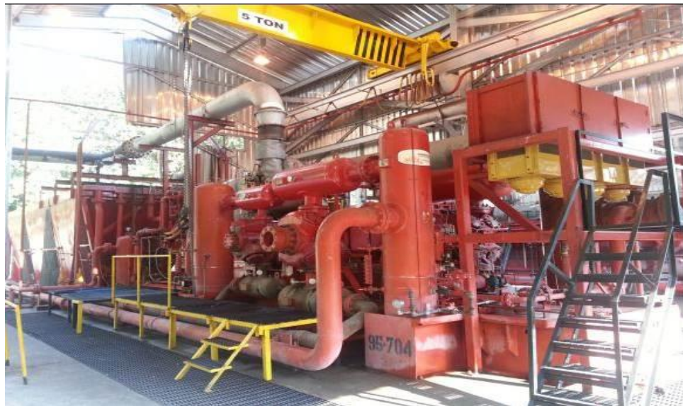
Figura 21. Unidad Compresora Independiente G3608 – 6HOS4
