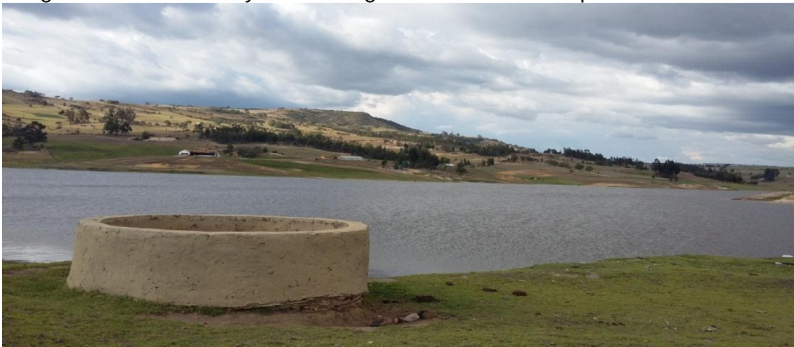
Imagen 20. Vista lateral y cobertura general del área Compuerta 2.
