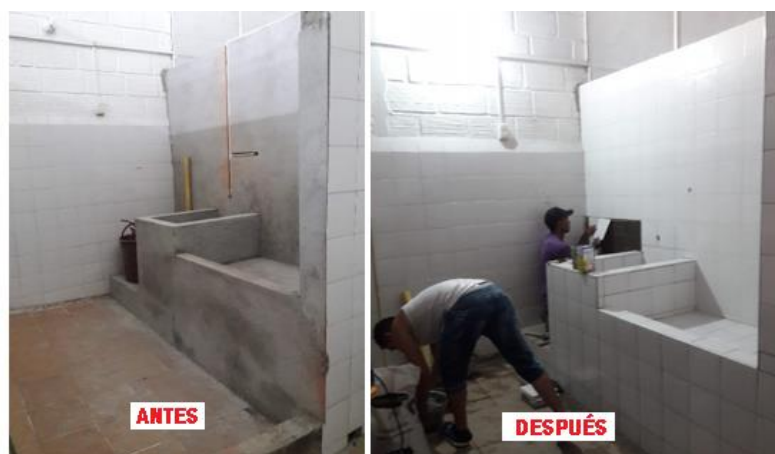
Figura 38. Antes y después de la adecuación del área de aseo.
