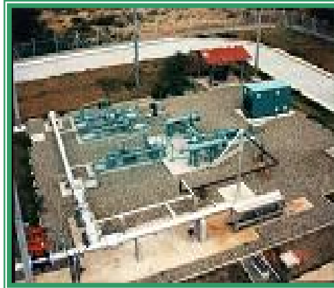
GASODUCTO CENTRO ORIENTE
