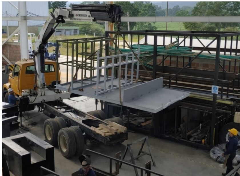
Figura 28. Equipo de izaje en elevación de plataforma.
