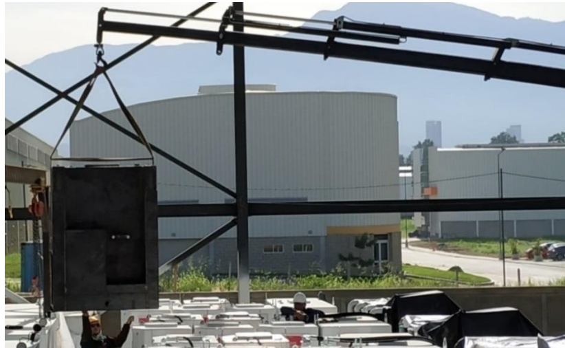
Figura 29. Equipo de izaje en elevación de tanques
