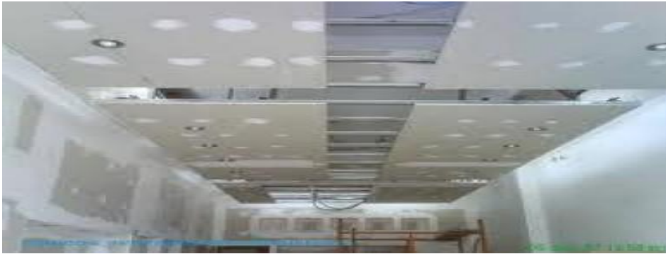
Figura 3. Renovación de techos
