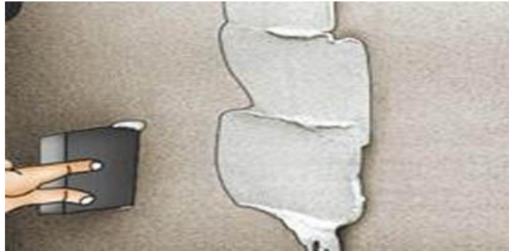
Figura 22. Tapar las juntas con masilla
