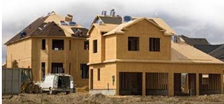
Figura 1. Remodelaciones con Drywall.
