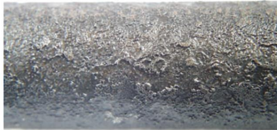
Figura 33. Corrosión por Acido
