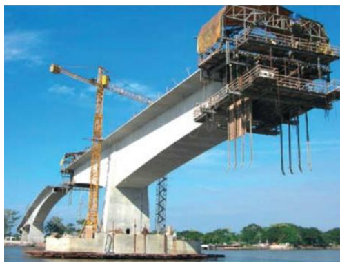
Imagen 42. Fundida de Dovela en el puente principal, Apoyo 7.
