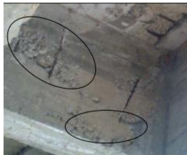
Imagen 11. Presencia de hormigoneo. Puente Rio Meldar. Tolima 2005.
