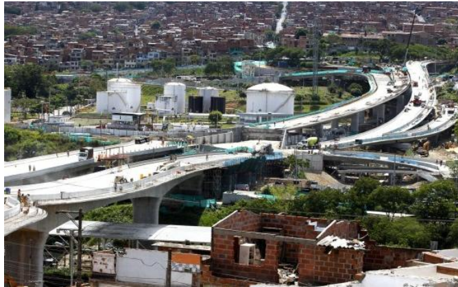
Imagen 47. Ejecución del Puente Madre Laura, Medellín
