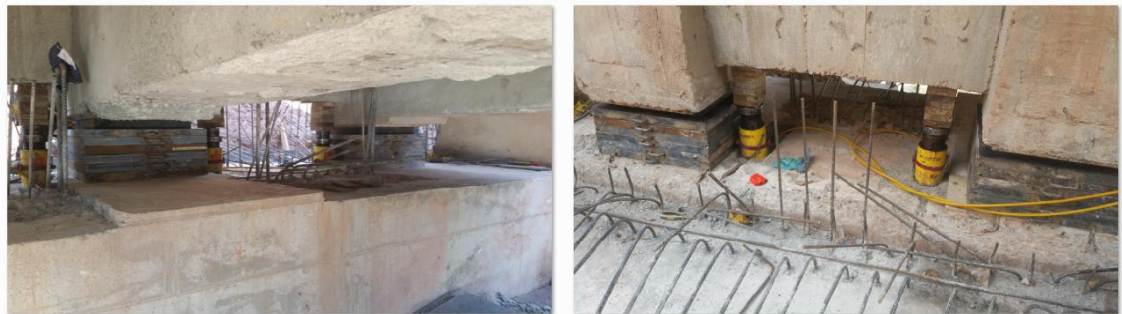
Imagen 84. Recalce de las vigas postensadas con platinas metálicas en estribo eje 6
