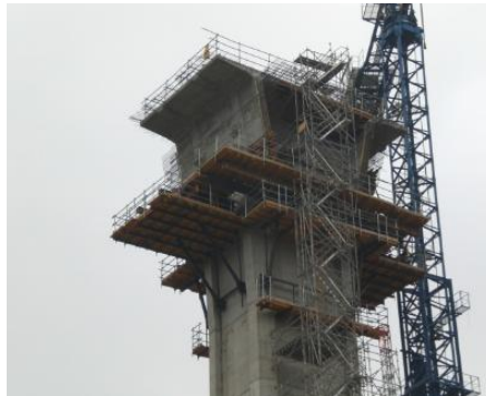
Imagen 4. Dovela "0" viaducto de Tenoya, Gran Canaria
