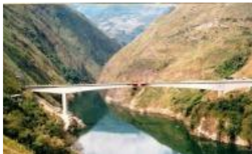
Imagen 35. Construcción Puente Farallones 1991
