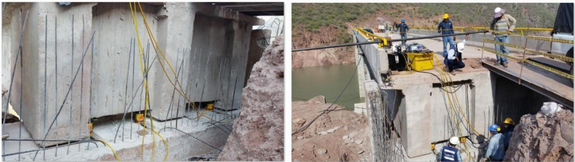
Imagen 82. Gateo de las vigas postensadas con sistema de control central de cargas
