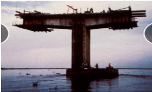
Imagen 6. Puente construido por voladizo sucesivo
