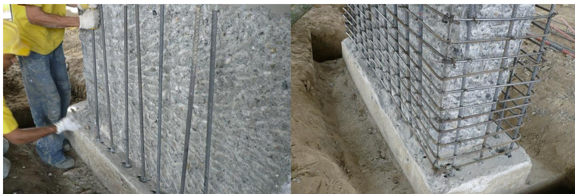
Imagen 27. Anclajes para recrecimiento de la estructura
