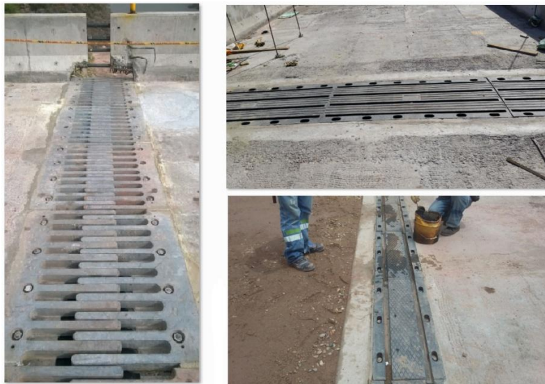
Imagen 86. Instalación de Juntas tipo freyssinet y VSL en eje 4,5 y 6
