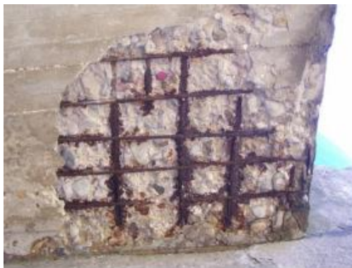
Imagen 19. Detalle de corrosión generalizada por carbonatación del hormigón
