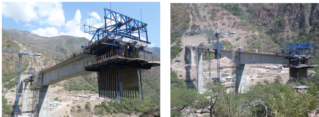
Imagen 55. Puente Geo Von Lengerke, Carros de avance
