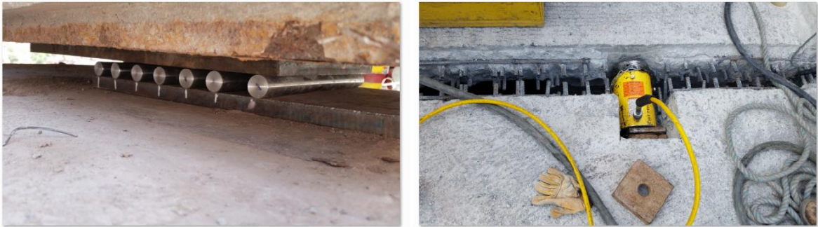
Imagen 83. Movimiento horizontal de las vigas para llevarlas a su posición original
