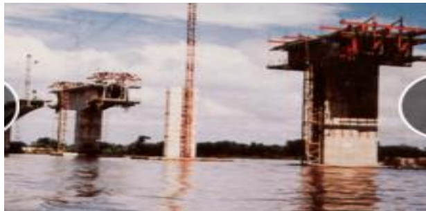
Imagen 34. Montaje de carros de avance en la construcción del puente Plato
