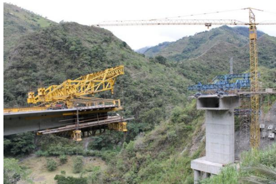
Imagen 43. Encofrado Puente Buga-Buenaventura
