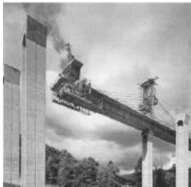
Imagen 5. Viaducto De Fréburge, Francia. Construcción usando torre móvil
