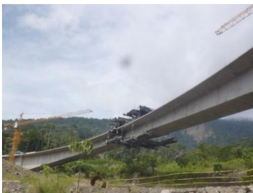
Imagen 52. Dovela de cierre Terminación obra Puente Mata de Cacao
