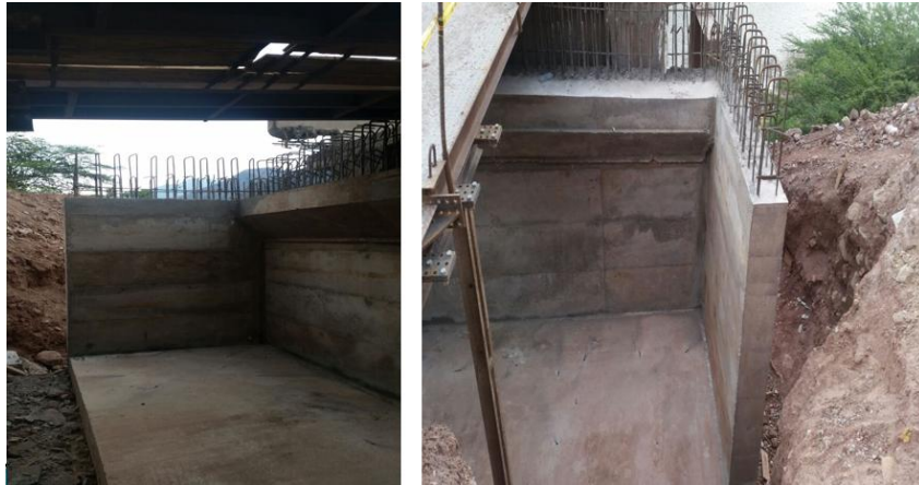
Imagen 85. Reconstrucción de Espaldar y aletas en estribo eje 6
