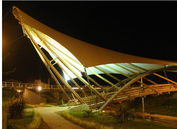
Figura 9. Puente de Guadua. Cúcuta, Norte de Santander
