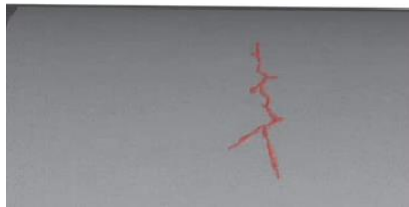
Imagen 41. Inspección con líquidos penetrantes
