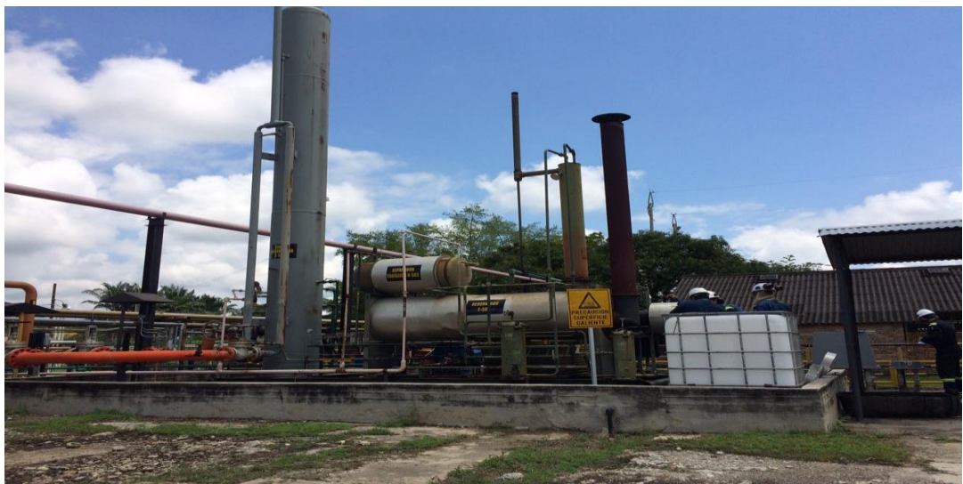
Fotografía 5. Espacio disponible cerca de la planta de glicol
