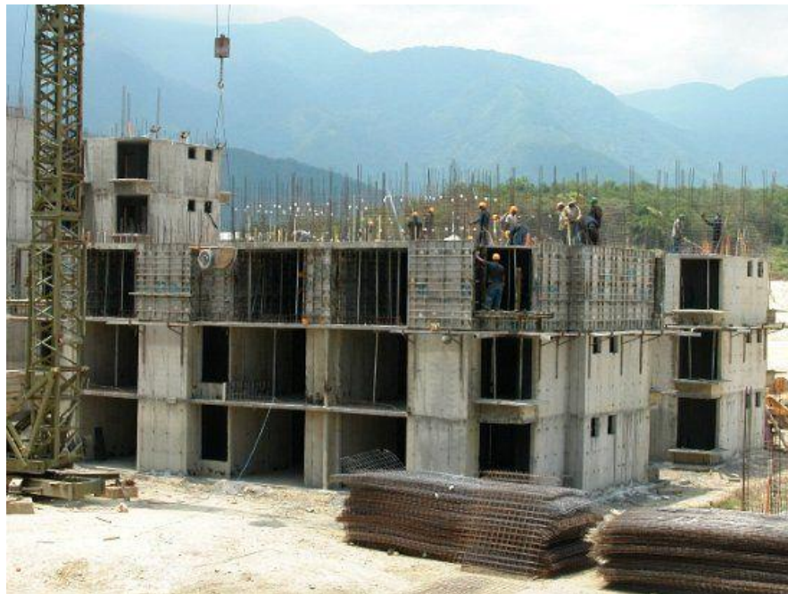
Figura 1. Edificaciones de baja altura en muros de concreto, Fuente: (Herrera, 2014)
