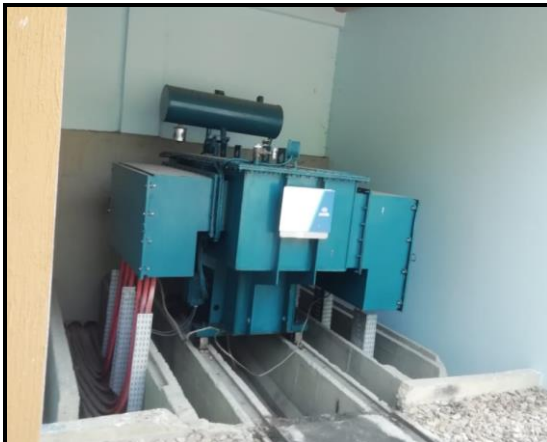
Figura 10. Autotransformador N° 1
