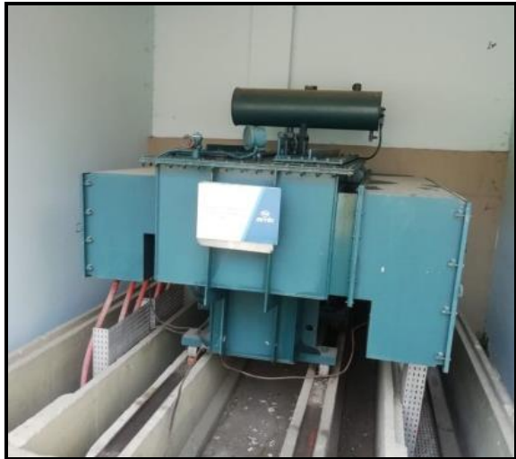
Figura 13. Autotransformador N° 4
