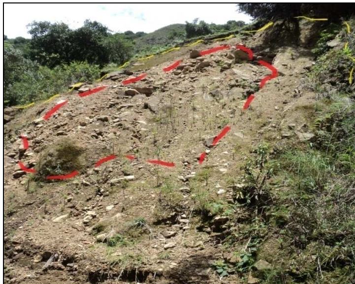
Figura 30. Bloques de roca dentro del deslizamiento sector 2
