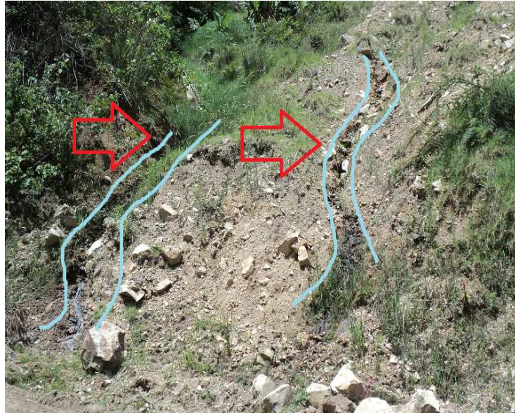
Figura 28. Generación de erosión en surcos Sector 2
