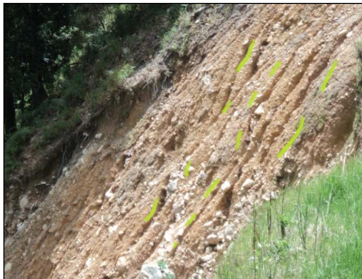
Figura 26. Surcos de Erosión ladera inferior de la vía
