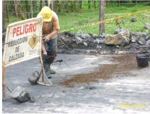
Figura 14. Riego de la emulsión
