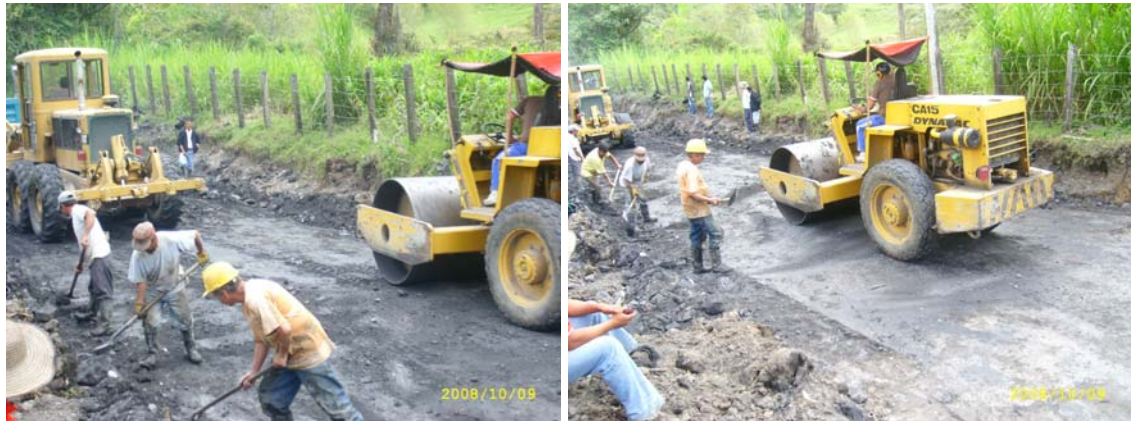
Figura 11.Compactación con vibro y mezclado. Figura 12.Compactación con vibro compactador
