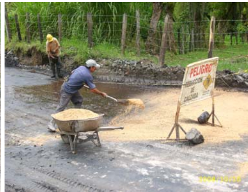
Figura 16. Riego de emulsión y arena
