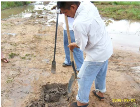
Figura 5. Realizando el apique
