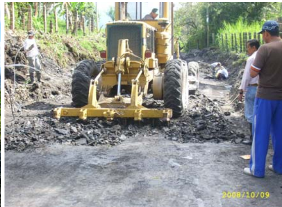
Figura 10. Escarificación para dar nivel
