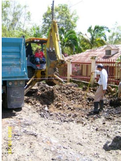
Figura 7. Escarificación para estabilizar
