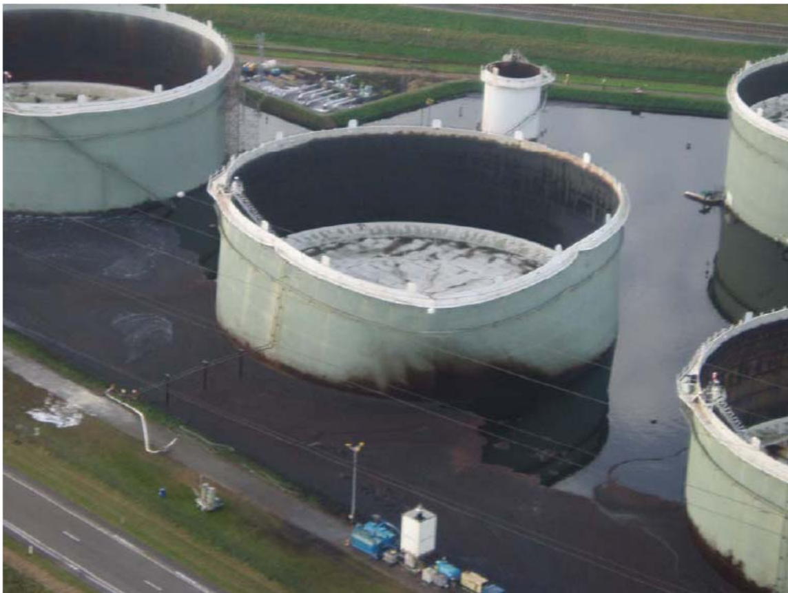
Figura 7 Fotografía del accidente en el tanque D2. Tomada de http://www.hse.gov.uk/comah/alerts/ong013.pdf
