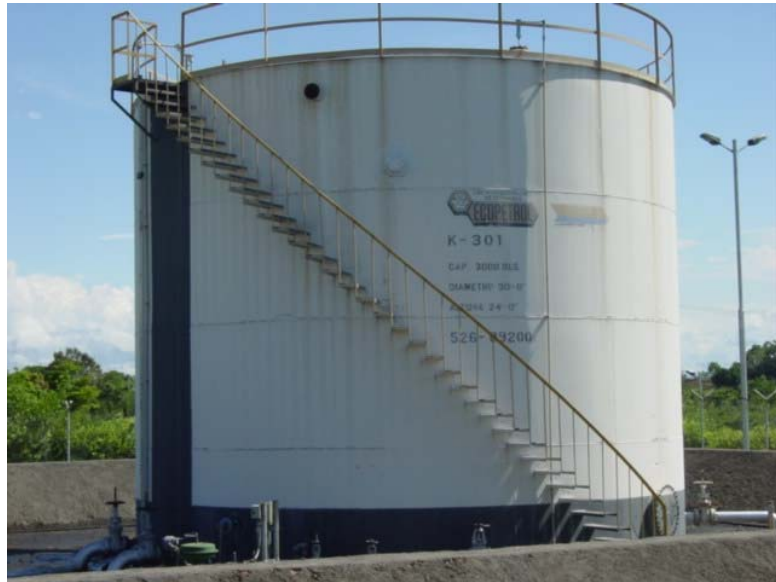
Figura 4 Tanque de almacenamiento. Estación de Campo CantaGallo- Colombia
