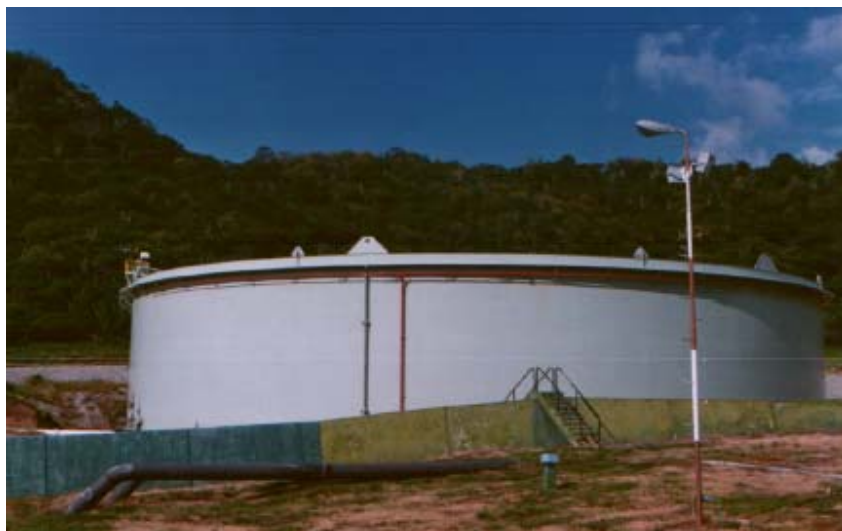
Figura 2 Tanque de Techo Flotante. Estación Puerto Salgar
