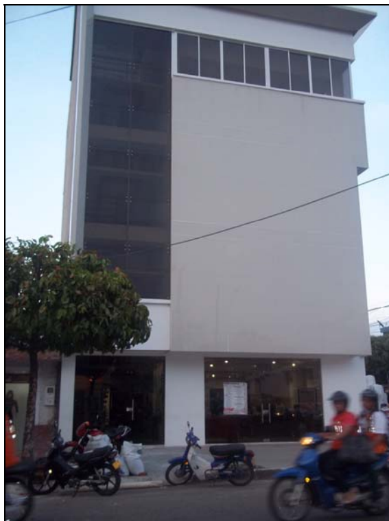
Figura 2. Vista lateral de entrepisos 1
