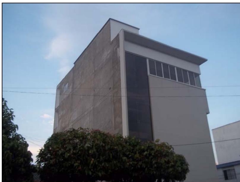
Figura 3. Vista lateral de entrepisos 2
