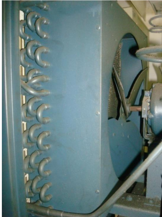
Figura 197. Condensador - Radiador.
