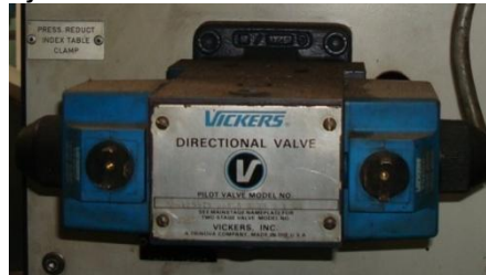
Figura 52. Válvula de anclaje de la Mesa de Indexación.
