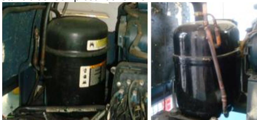
Figura 133. Cambio del Compresor del Chiller.
