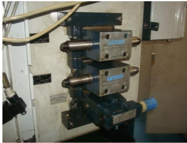
Figura 85. Montaje de válvulas en manifold.
