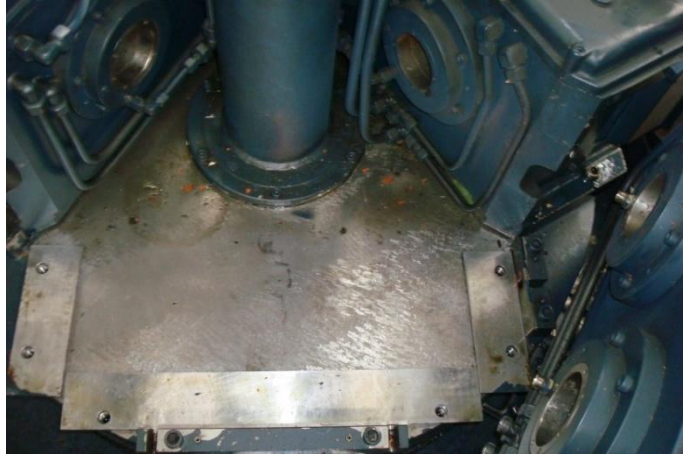
Figura 221. Módulo de Trabajo desmontado.
