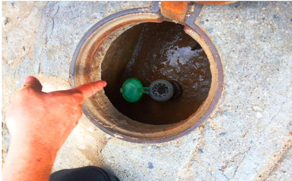
Anexo S. Caja de Inspección Punto "José A. Galán"
