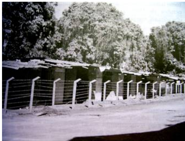
Figura 9. Cerramiento del Parque Centenario llevado a cabo por la CDMB en 6 horas. Fotografía de Vanguardia, 31 de Octubre de 1987
